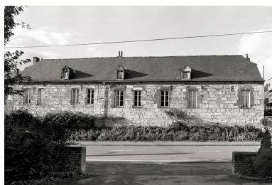
Vue de face. Phot. Pierre-Yves Brest IVR22_19990204229Z
