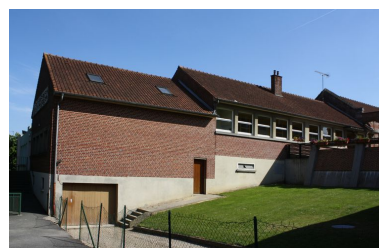
Façade postérieure de l'école maternelle élevée dans le prolongement de l'ancienne école des garçons. Phot. Bertrand Fournier IVR22_20098005021NUCA
