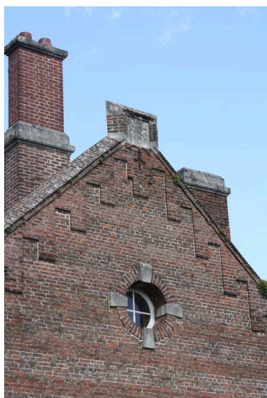
Sommet du pignon de la mairie portant la date de 1883.
