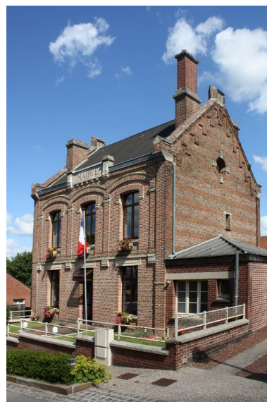
Vue d'ensemble. Phot. Bertrand Fournier IVR22_20088015427NUCA
