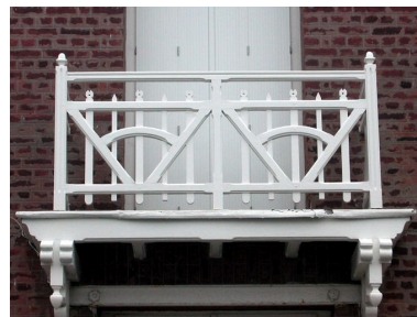
Détail du balcon. Phot. Elisabeth Justome IVR22_20058002694NUCA
