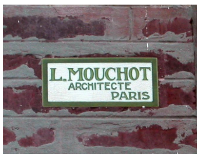
Détail de la plaque en céramique portant signature de l'architecte. Phot. Elisabeth Justome IVR22_20058002695NUCA
