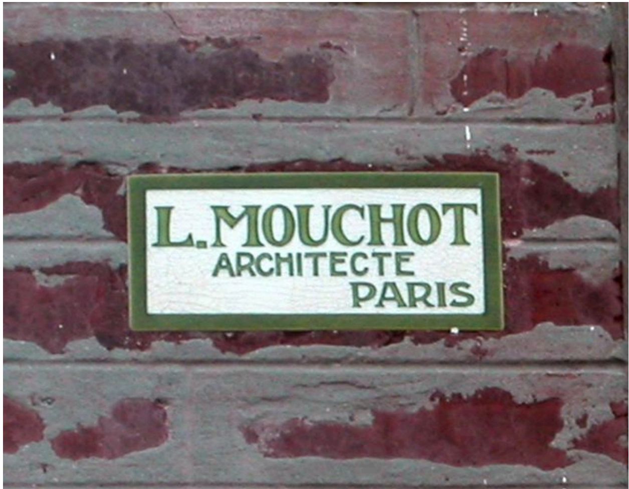
Détail de la plaque en céramique portant signature de l'architecte.
