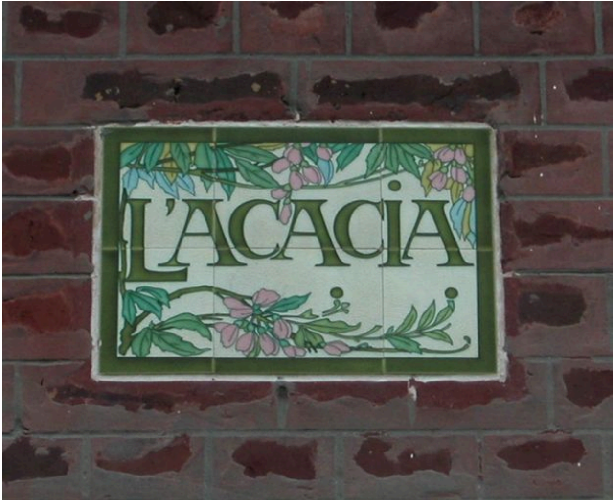
Détail du carreau de céramique portant appellation.
