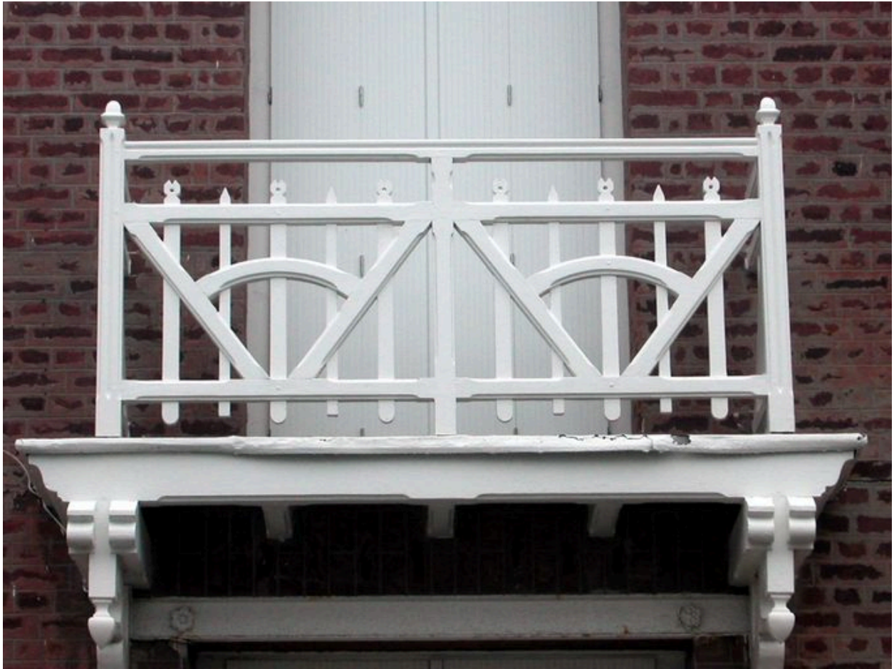
Détail du balcon.
