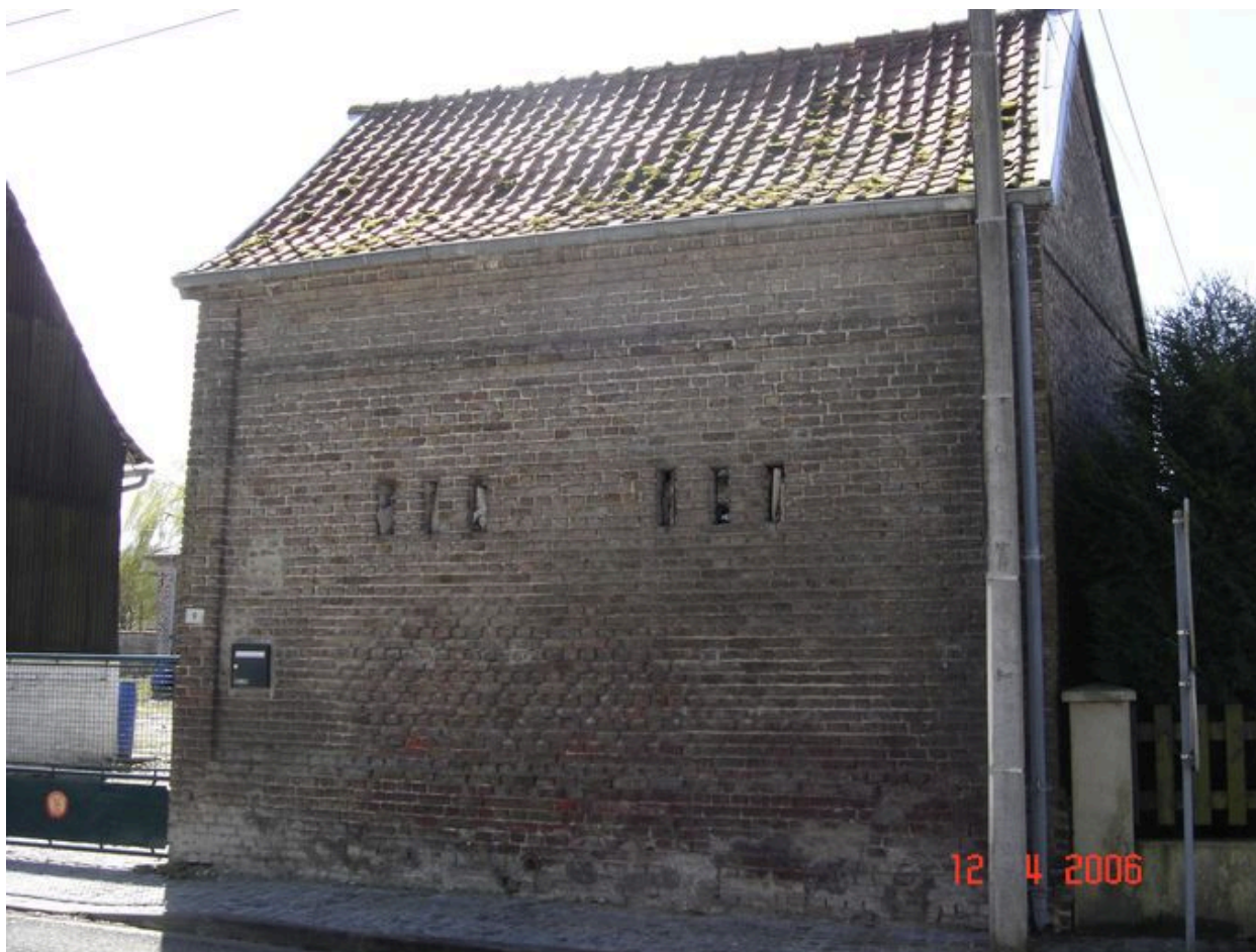
Vue des étables en brique à l'ouest de la cour depuis la rue.
