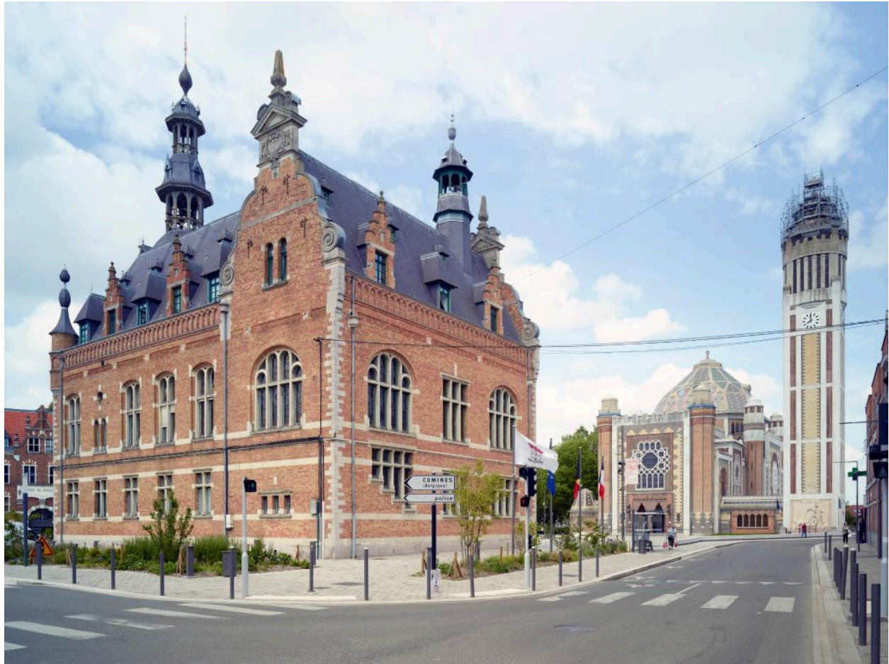
Vue d'ensemble depuis ouest.
