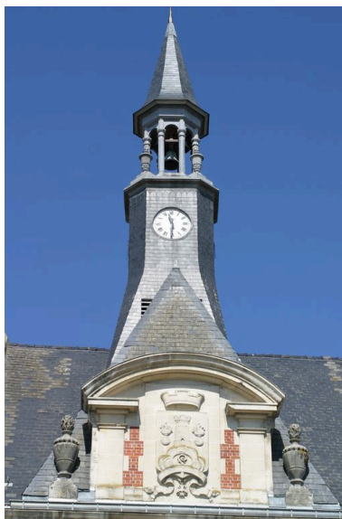
Détail du clocher. Phot. Inès Guérin IVR22_20030202243NUCA
