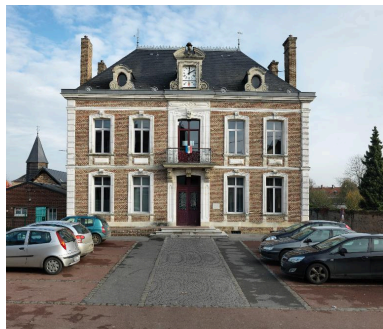
Vue d'ensemble sur rue. Phot. Thierry Lefébure IVR22_20138000517NUC2AQ
