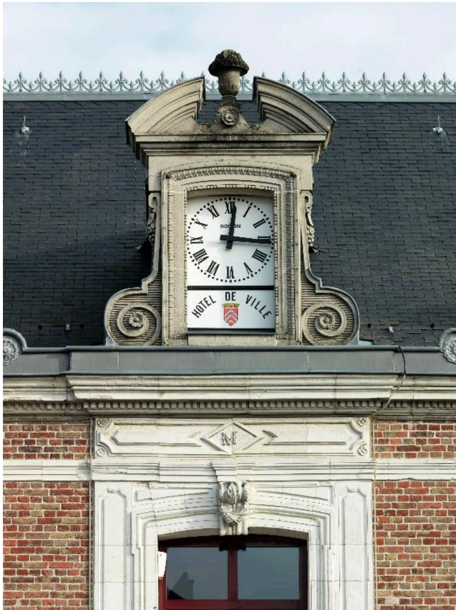
Façade sur rue, détail de la lucarne.
