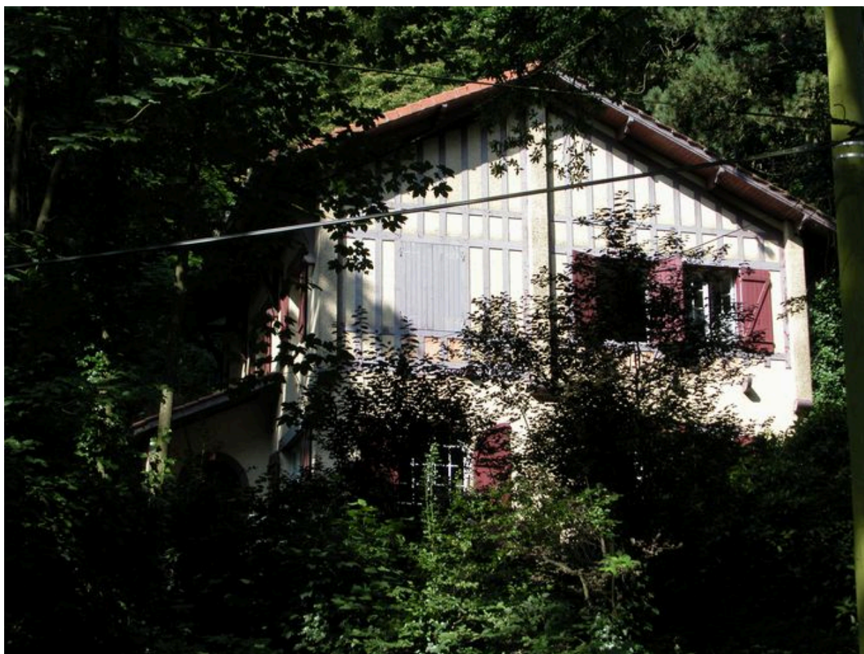
Vue d'ensemble depuis la rue.
