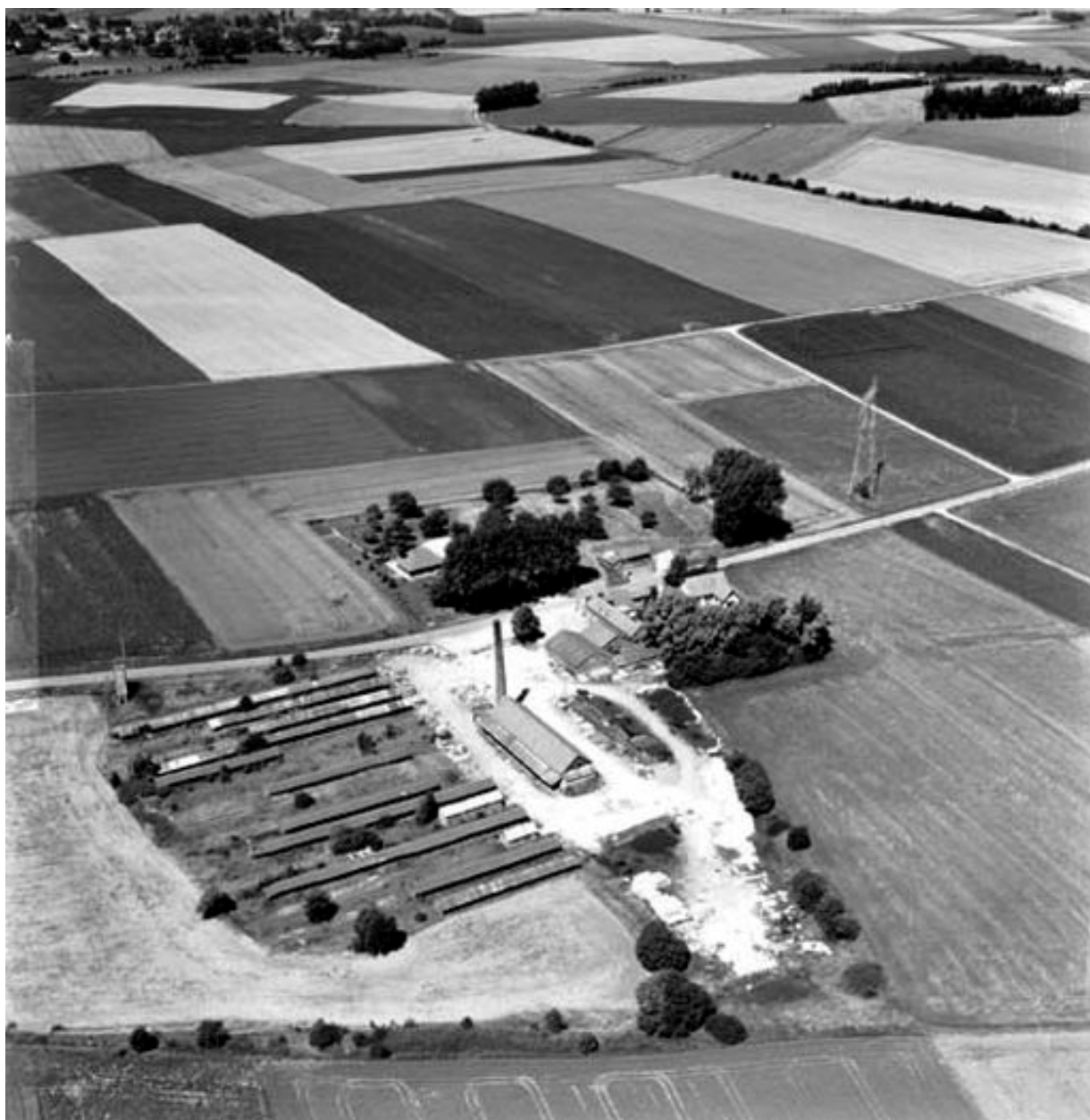
Vue aérienne, flanc sud.
