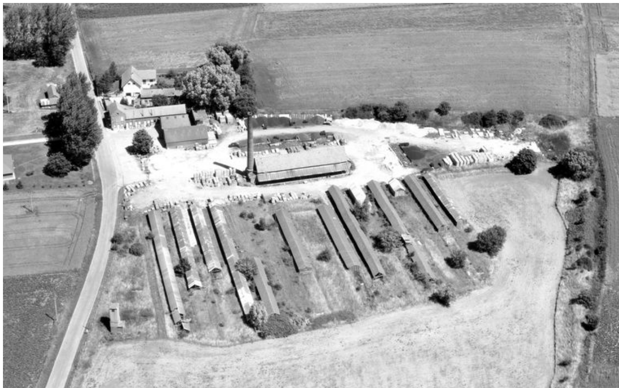
Vue aérienne, flanc sud.
