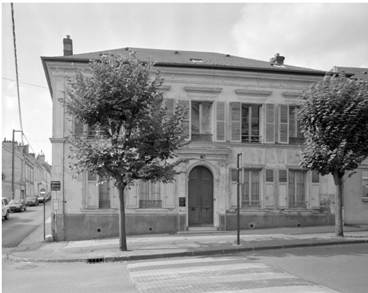
Maison, 32 avenue de Soissons.
