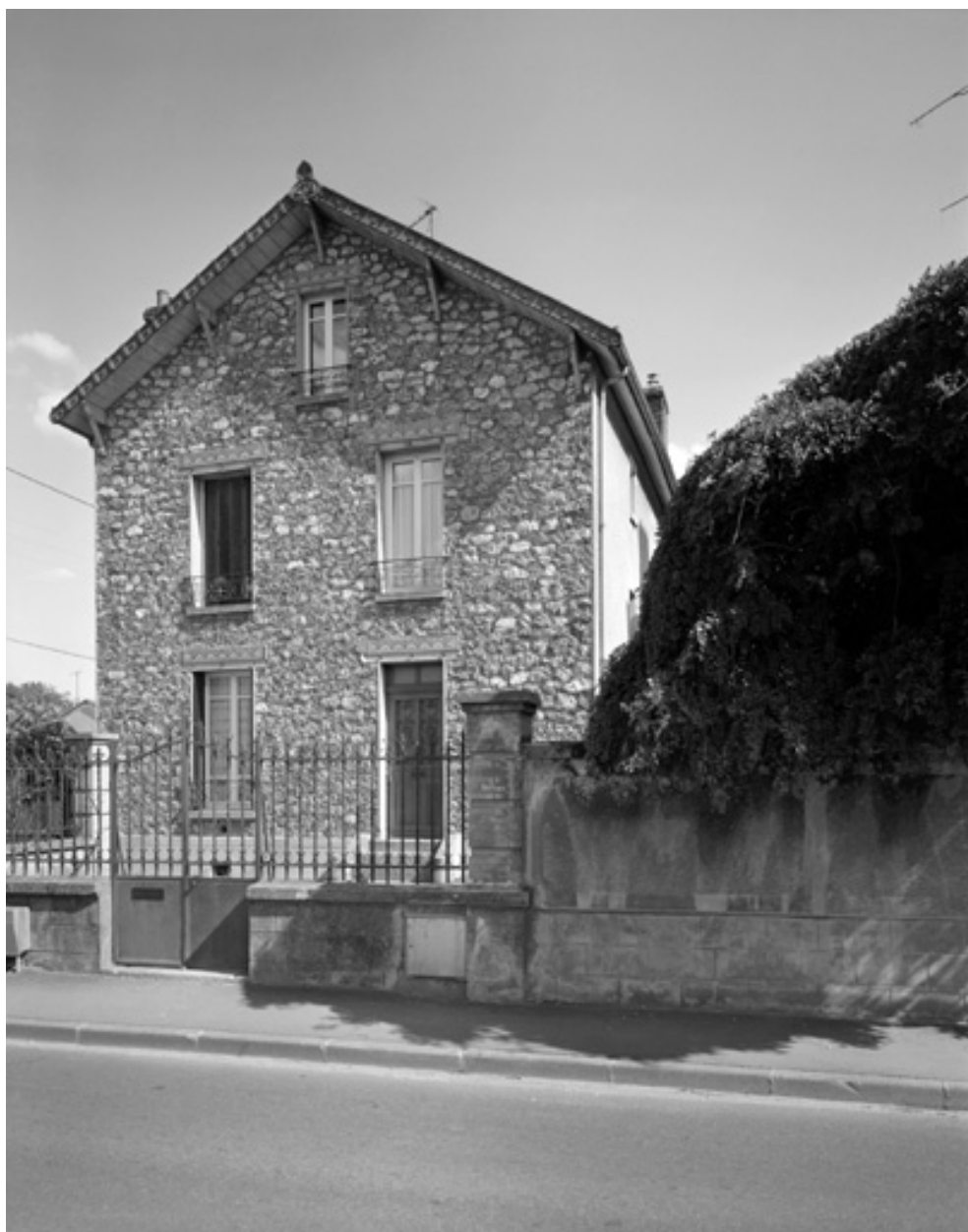
Maison, 20 avenue d'Essômes. Vue depuis la rue.
