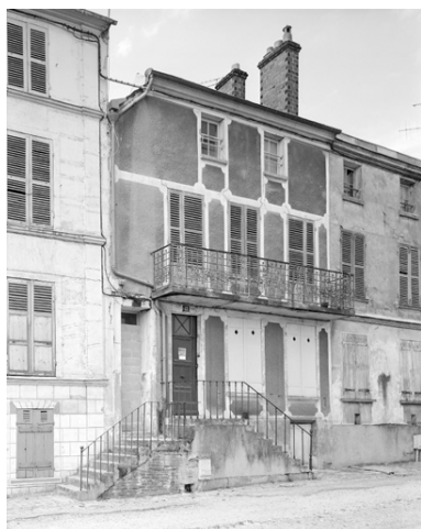
Maison, 12 avenue Joussaume-Latour. Phot. Thierry Lefébure IVR22_19950200335V
