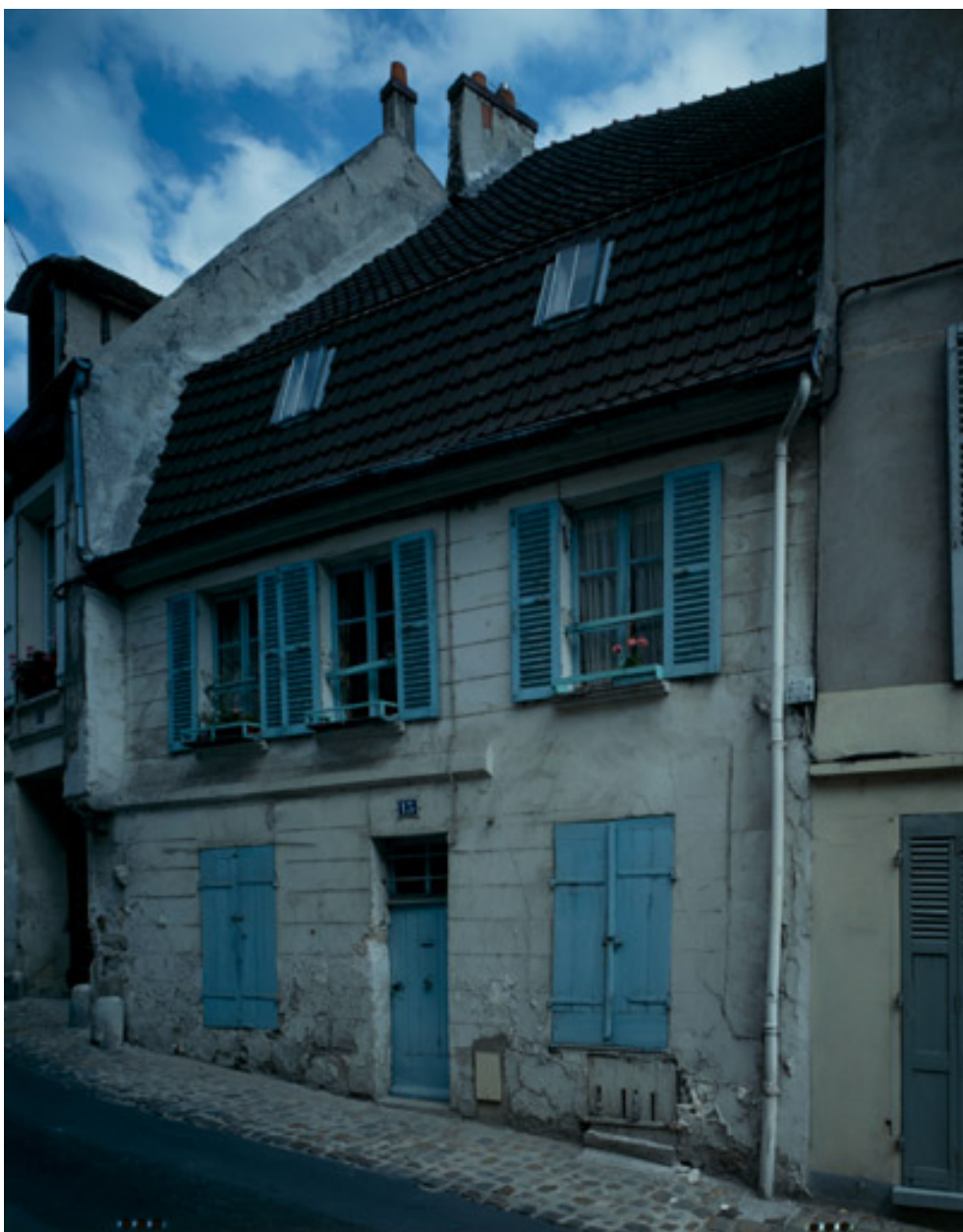
Maison, 15 rue du Château.
