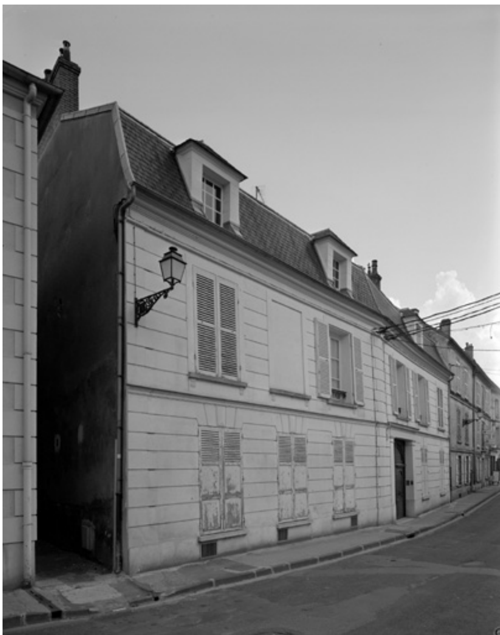
Hôtel, 32 rue Saint-Martin. Vue depuis la rue.
