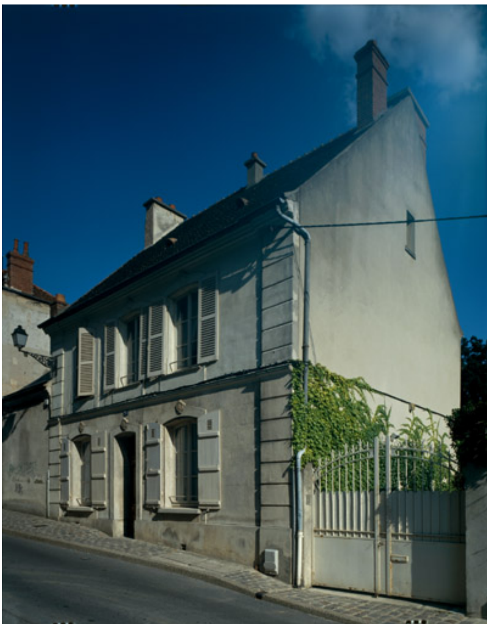
Maison, 24 rue Saint-Martin. Vue depuis la rue.
