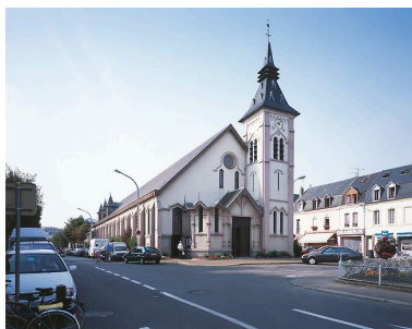
Vue générale. Phot. Philippe Dapvril IVR31_20046200118VA
