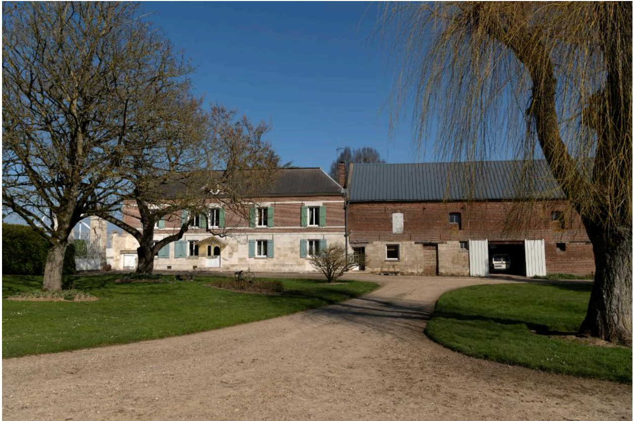
Vue générale du logis et du bâtiment des étables et écuries depuis le sud.
