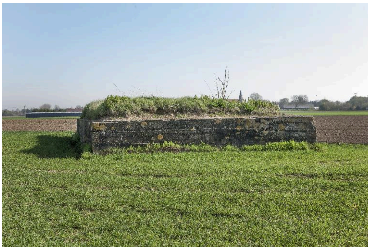
Vue générale vers le nord-est
