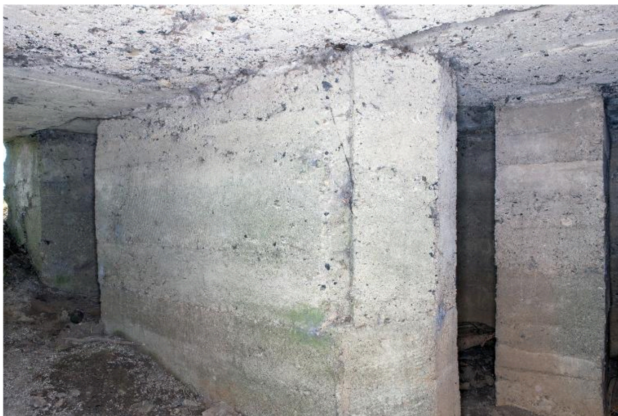
Couloir, vers l'entrée sud-est
