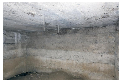
Salle ouest Phot. Pierre Thibaut IVR31_20155901663NUCA
