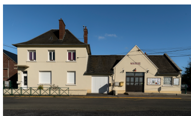
Logement de l'instituteur et mairie, années 1950, n°3 de la rue Yves-Maréchal, vue depuis l'ouest. Phot. Marc Kérignard IVR32_20246001272NUCA
