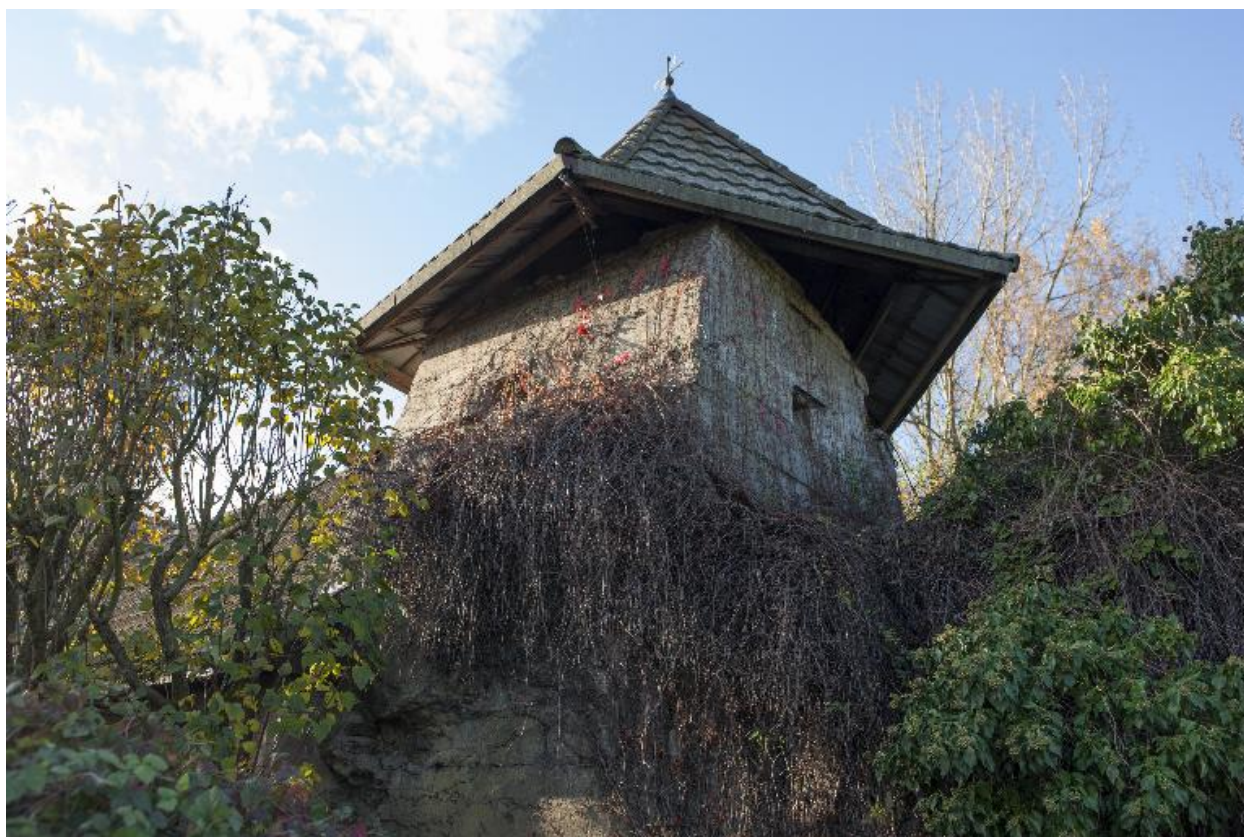
Sommet de l'observatoire, vers le nord-ouest
