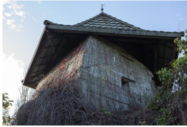
Sommet de l'observatoire Phot. Jean-Marc Ramette IVR32_20175901090NUCA
