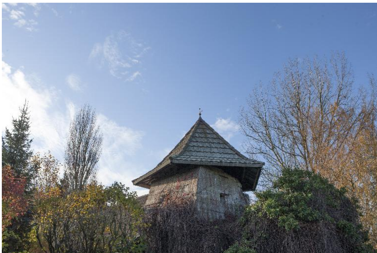
Sommet de l'observatoire, vers le nord-ouest
