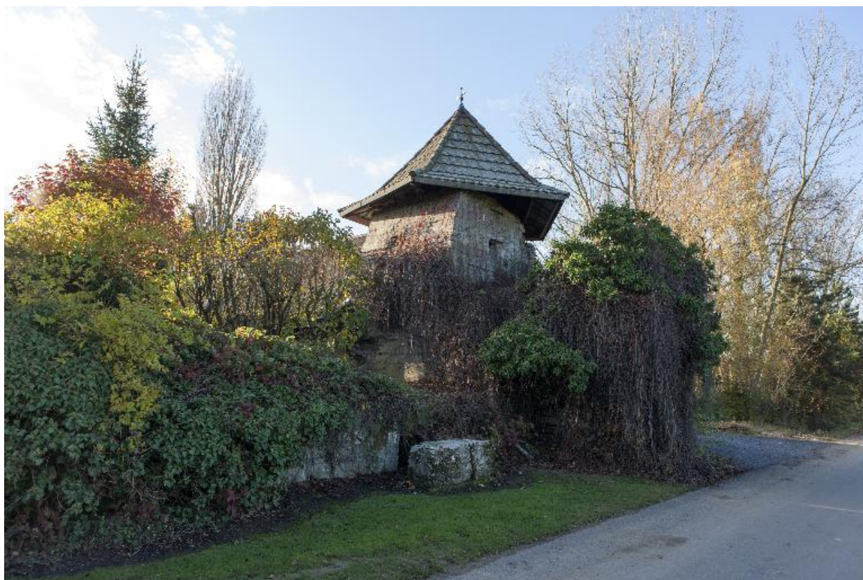
Vue générale vers le nord-ouest
