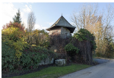
Vue générale vers le nord-ouest IVR32_20175901091NUCA
