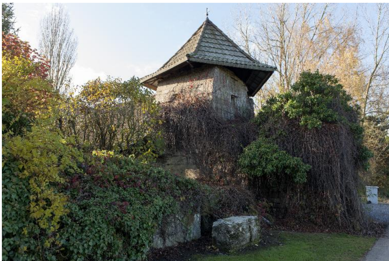
Vue générale, vers le nord-ouest
