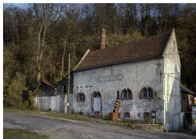
Vue de l'élévation nord-ouest de l'atelier de fabrication. Phot. Thierry Lefébure IVR22_19890200709XA
