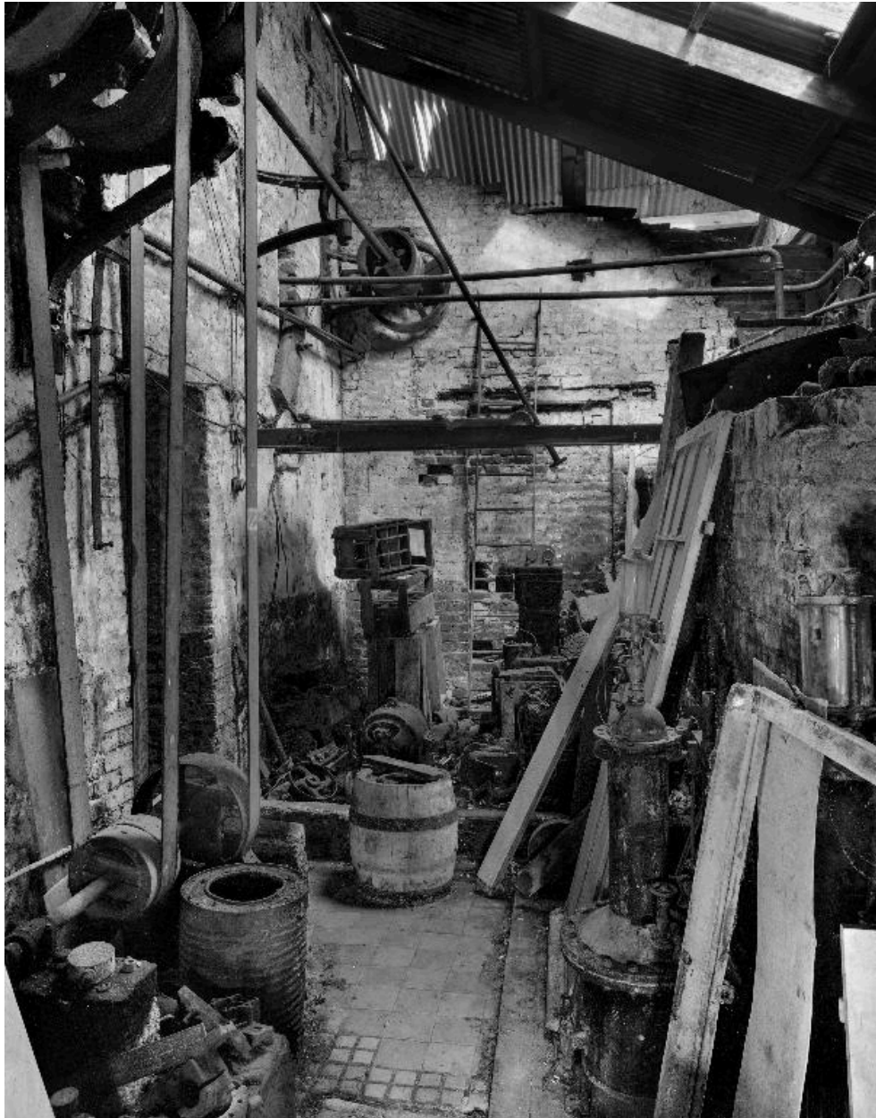
Vue partielle de l'atelier de fabrication.
