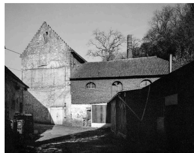
Élévation sur cour de l'atelier de fabrication. Phot. Thierry Lefébure IVR22_19890200691V
