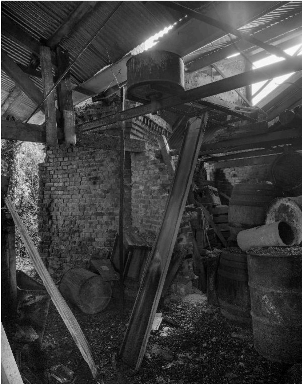
Vue de la base de la cheminée.
