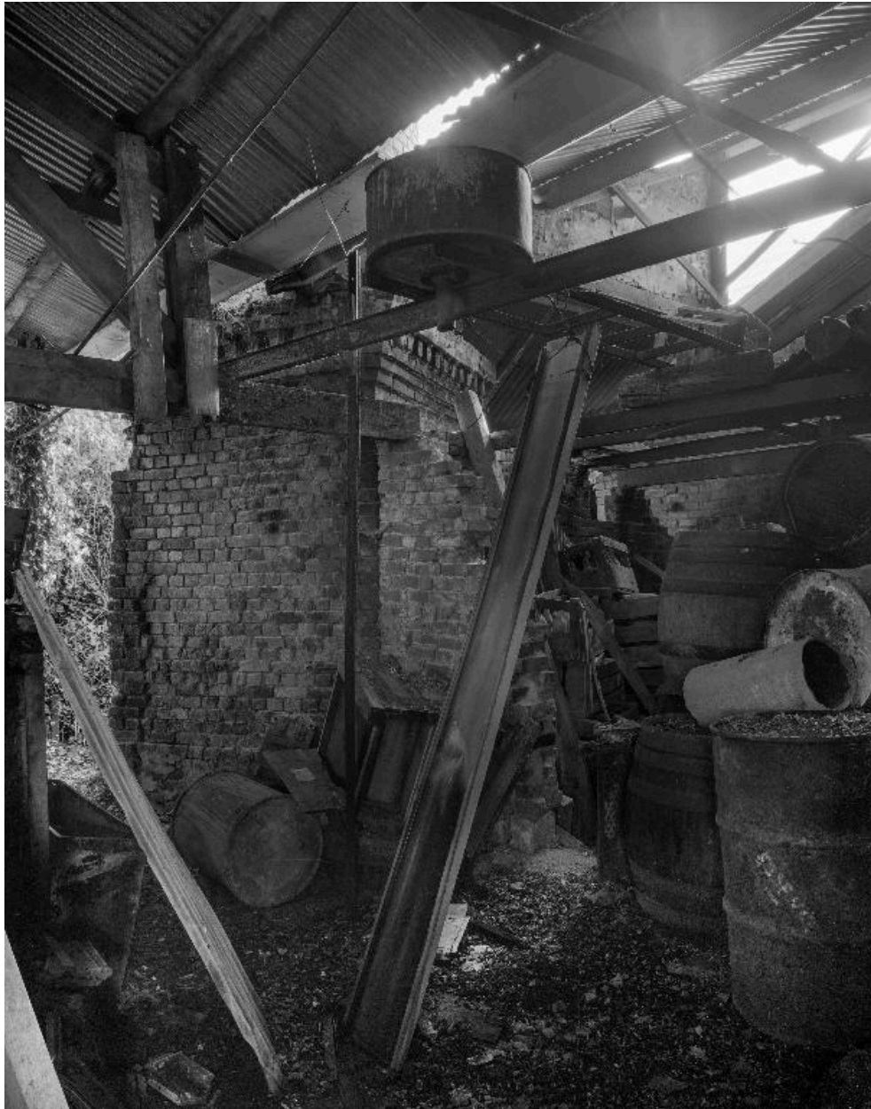
Vue de la base de la cheminée.
