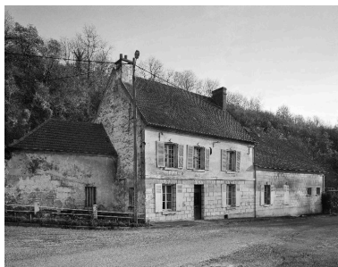
Vue de l'élévation antérieure du logement. Phot. Thierry Lefébure IVR22_19890200690V
