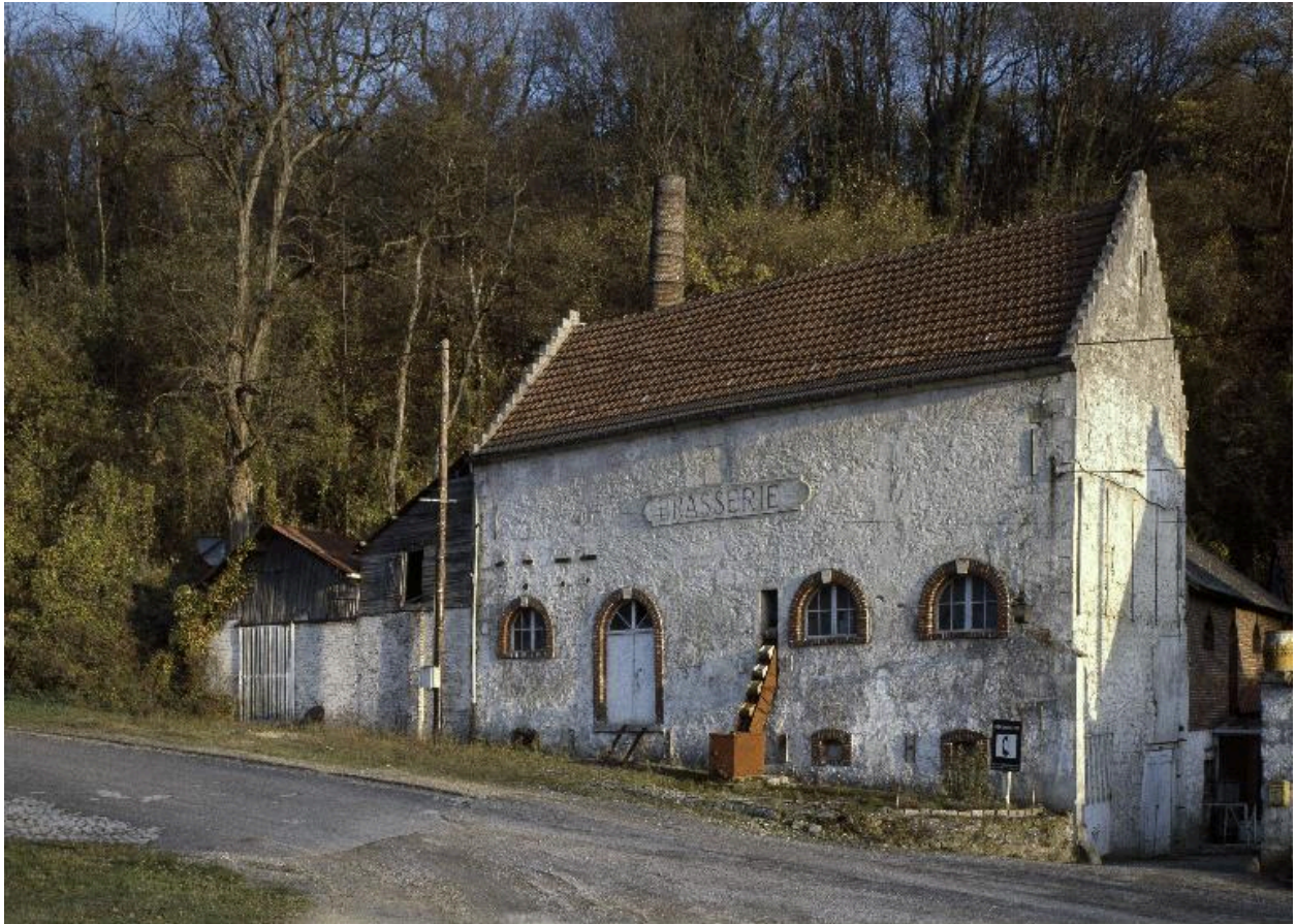
Vue de l'élévation nord-ouest de l'atelier de fabrication.
