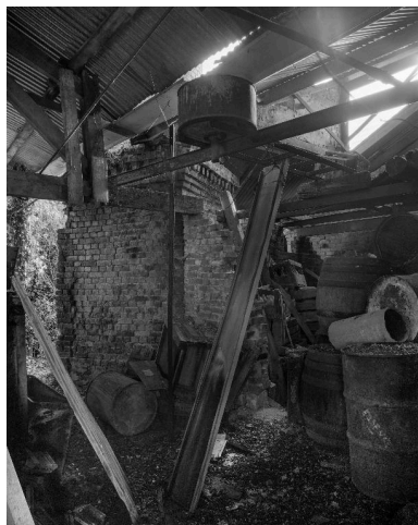
Vue de la base de la cheminée. Phot. Thierry Lefébure IVR22_19890200692V
