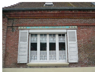
Détail de la baie large.
