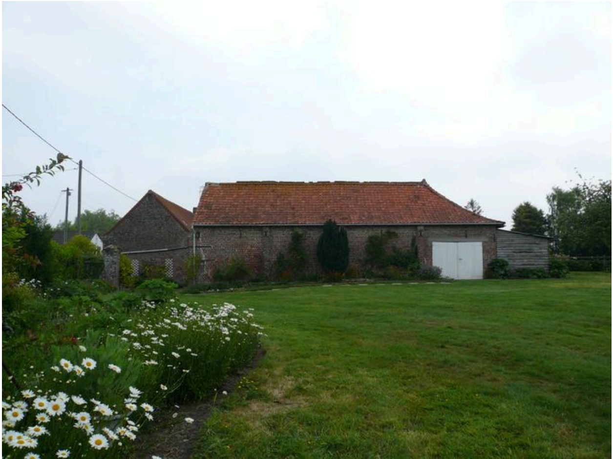
Vue latérale de la charretterie depuis la pâture bordant la propriété.
