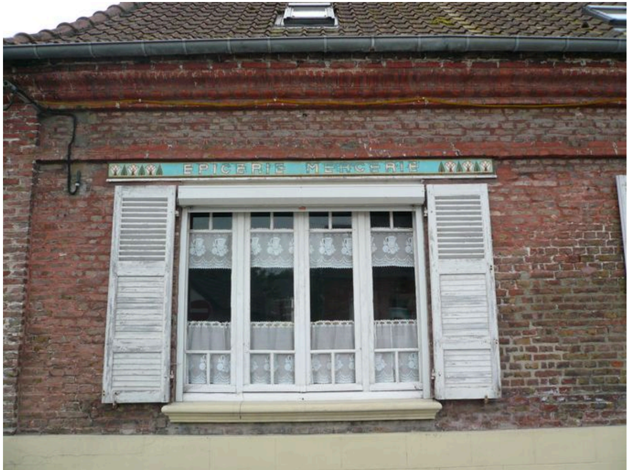
Détail de la baie large.
