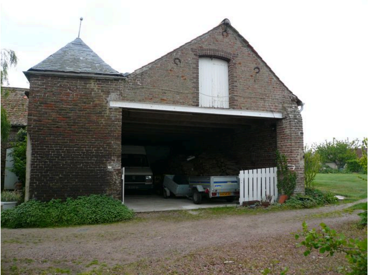
Vue sur la charretterie augmentée du grenier, située à l'entrée de la partie ferme.
