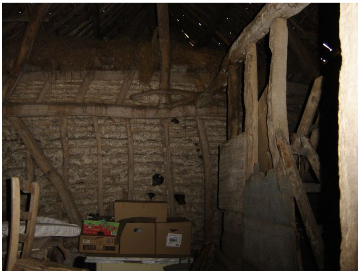
Vue intérieure de la grange.
