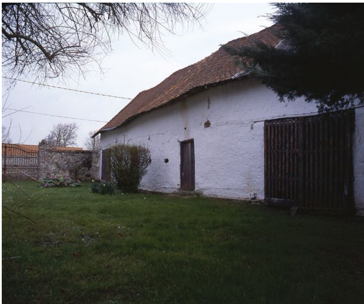
Vue de la grange.
