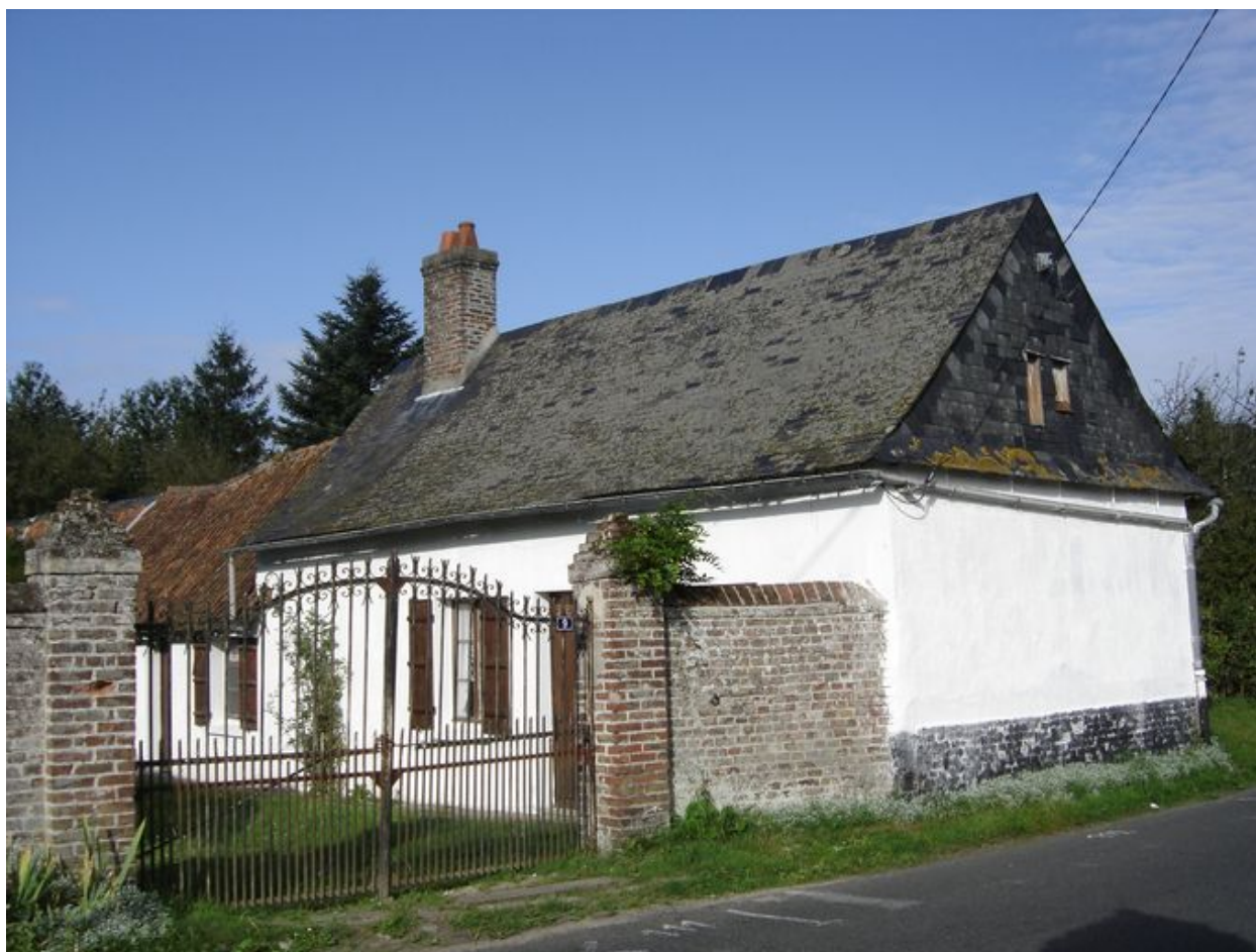
Vue du logis sur rue.
