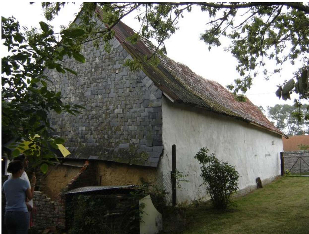
Vue postérieure du bâtiment.
