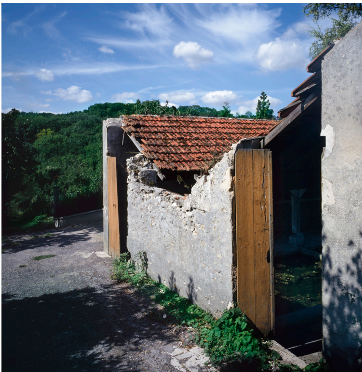
Lavoir : vue depuis la rue.
