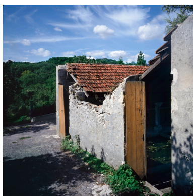
Lavoir : vue depuis la rue.
