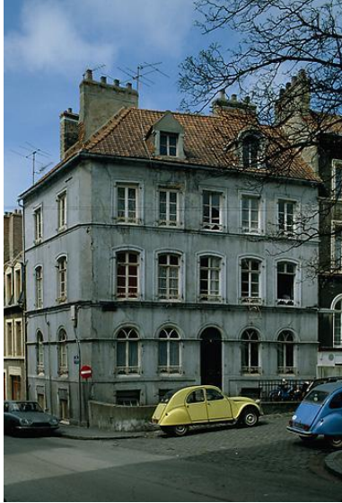
Vue d'angle sur voies. Phot. Jean-Michel Périn IVR31_19836200147ZA
