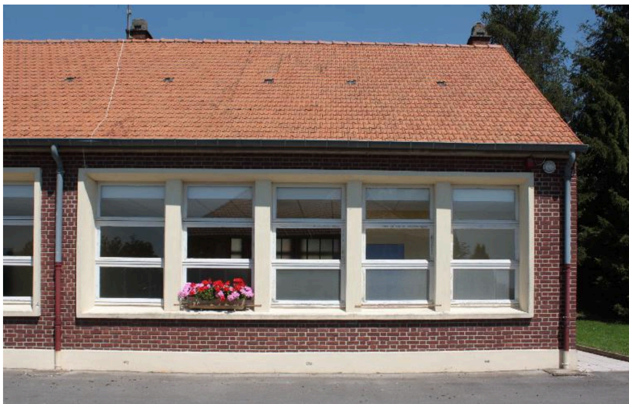
Détail d'une travée, façade sud.
