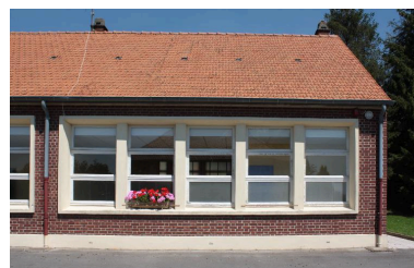
Détail d'une travée, façade sud. Phot. Bertrand Fournier IVR22_20128005161NUCA
