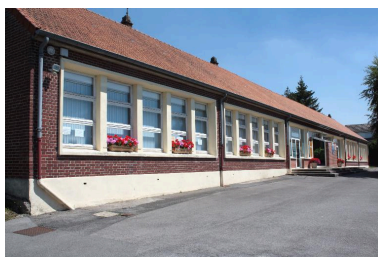
Vue de trois-quarts sud. Phot. Bertrand Fournier IVR22_20128005160NUCA
