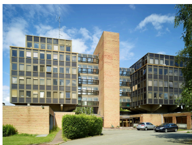
La façade nord du bâtiment administratif. Phot. Pierre Thibaut IVR32_20195900389NUCA
