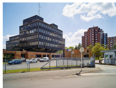
Vue d'ensemble depuis l'entrée, boulevard de Mons. Phot. Pierre Thibaut IVR32_20195900392NUCA
