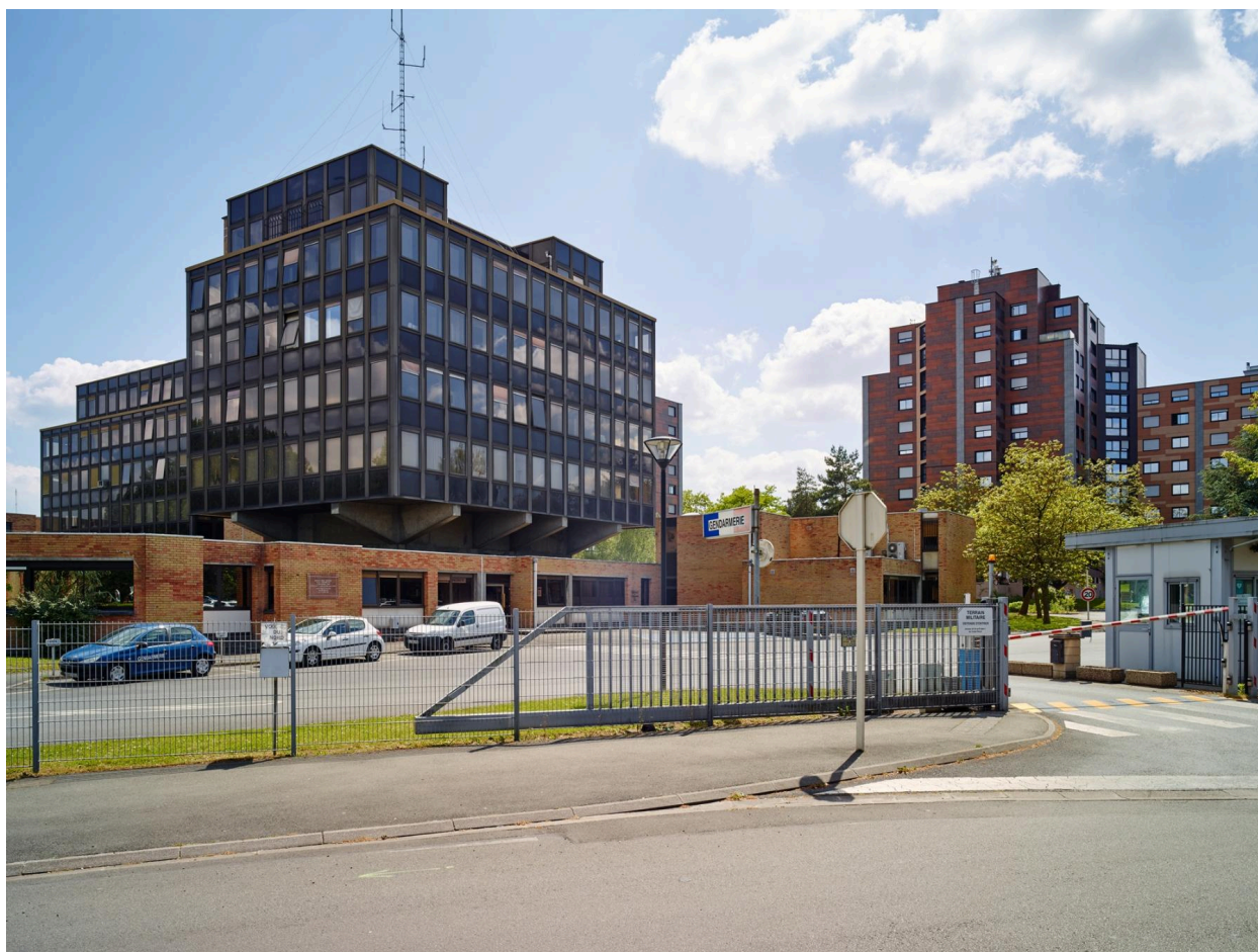
Vue d'ensemble depuis l'entrée, boulevard de Mons.
