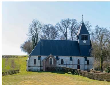
Vue générale de l'élévation nord. Phot. Marc Kérignard IVR32_20256000135NUCA
