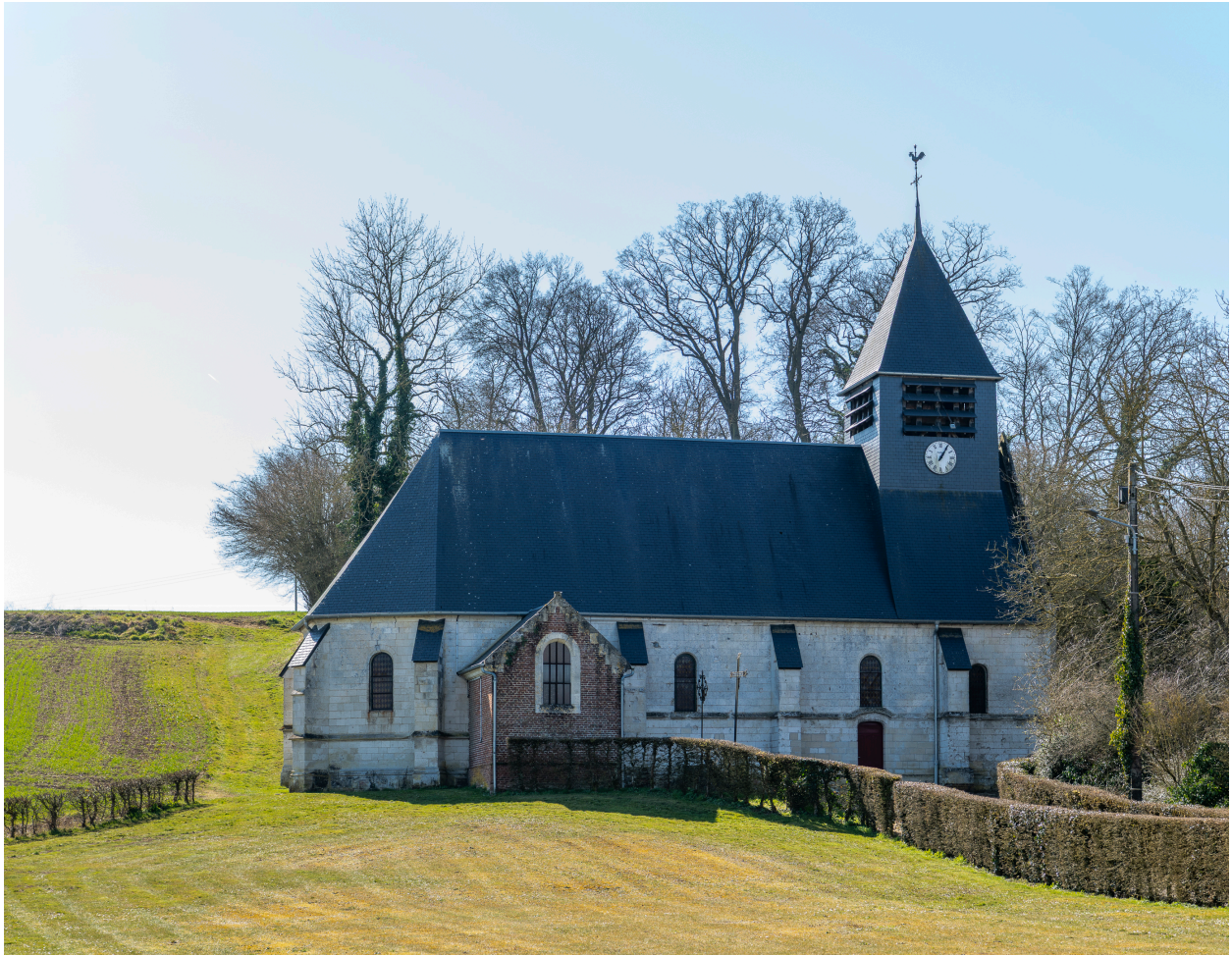
Vue générale de l'élévation nord.
