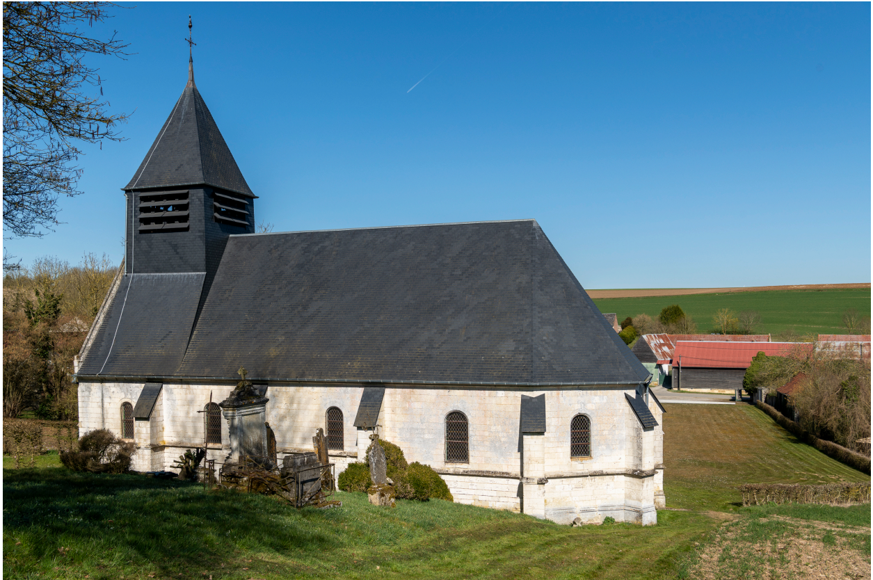
Vue générale de l'élévation sud.
