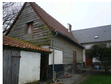
Vue de l'étable depuis la cour postérieure. Phot. Inès Guérin IVR22_20078005456NUCA
