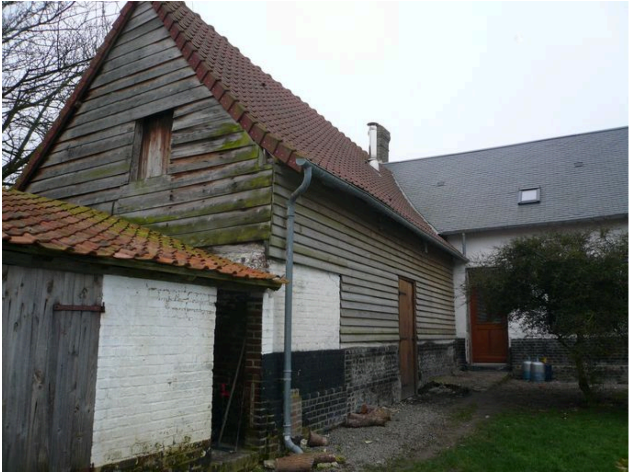
Vue de l'étable depuis la cour postérieure.
