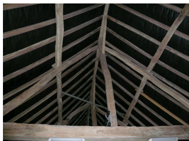
Vue détaillée d'une des fermes de la charpente. Phot. Inès Guérin IVR22_20078005457NUCA
