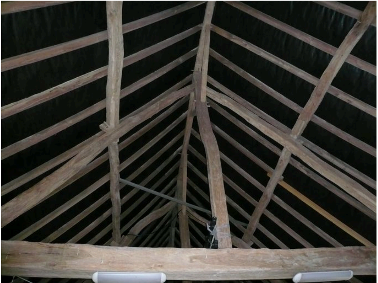
Vue détaillée d'une des fermes de la charpente.
