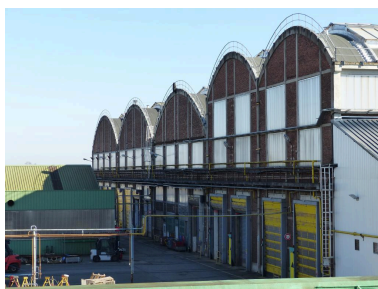
Façades nord des ateliers.
