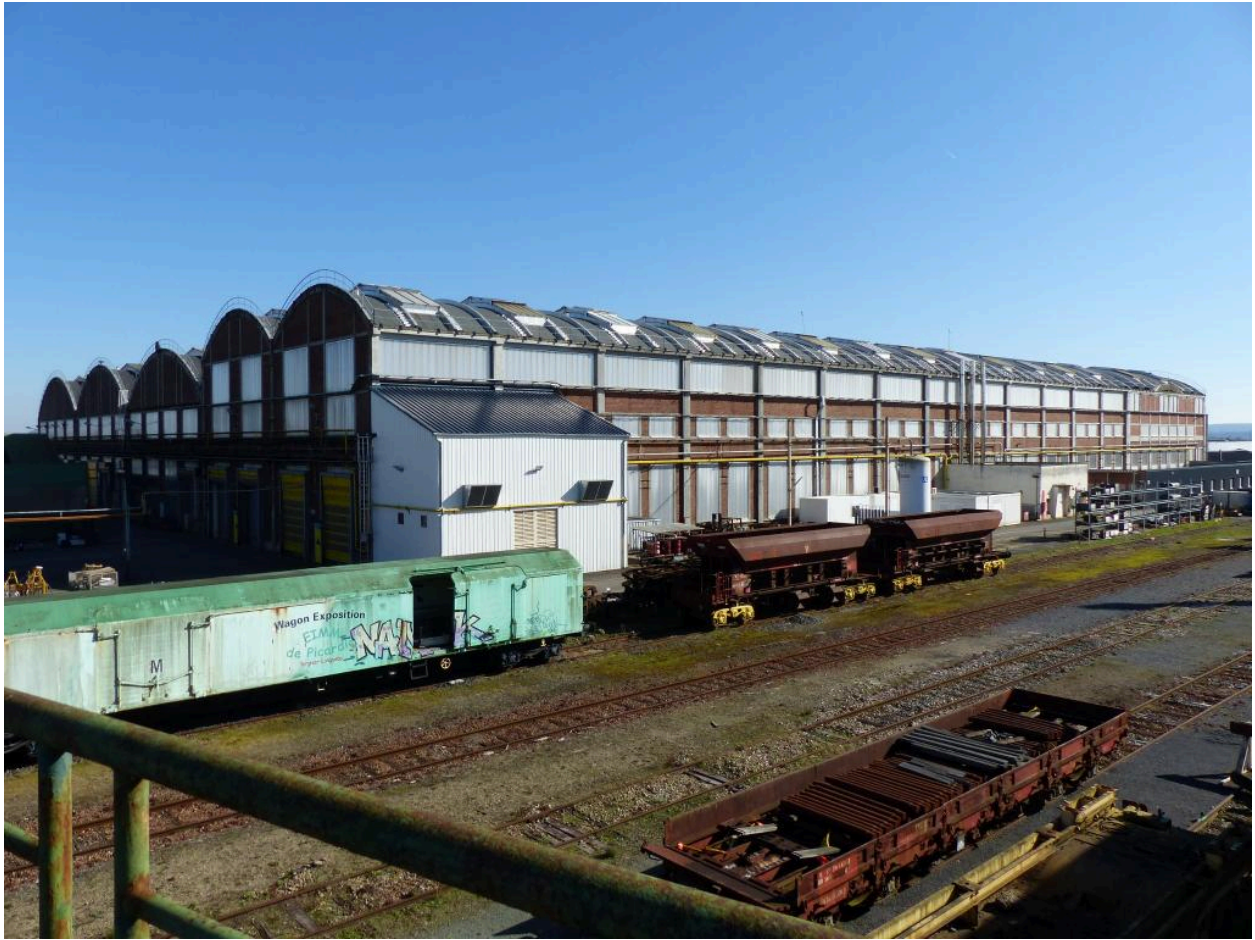
Les ateliers vus de la grande passerelle.
