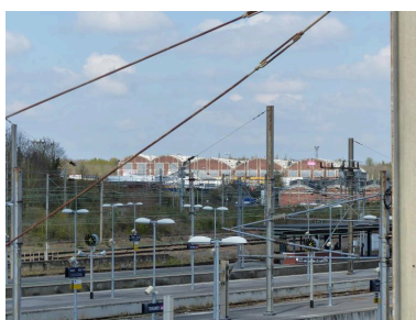
Vue de situation des ateliers du matériel roulant, depuis la passerelle de la gare.
