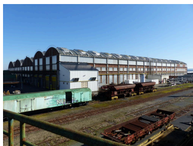
Les ateliers vus de la grande passerelle.
