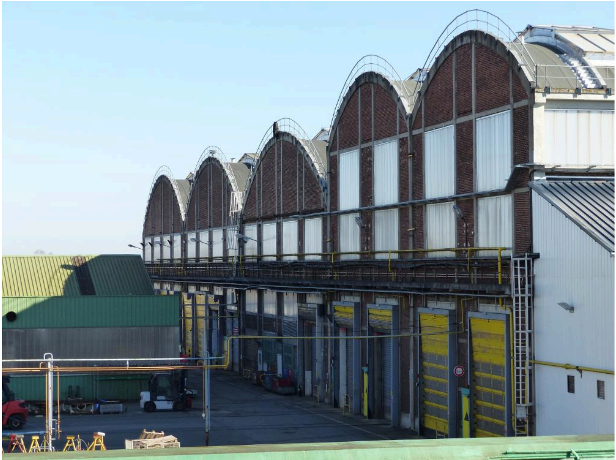
Façades nord des ateliers.
