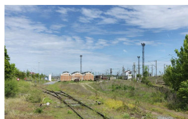
Vue des voies et des vestiges des anciennes halles de transbordement, au sud des ateliers.
