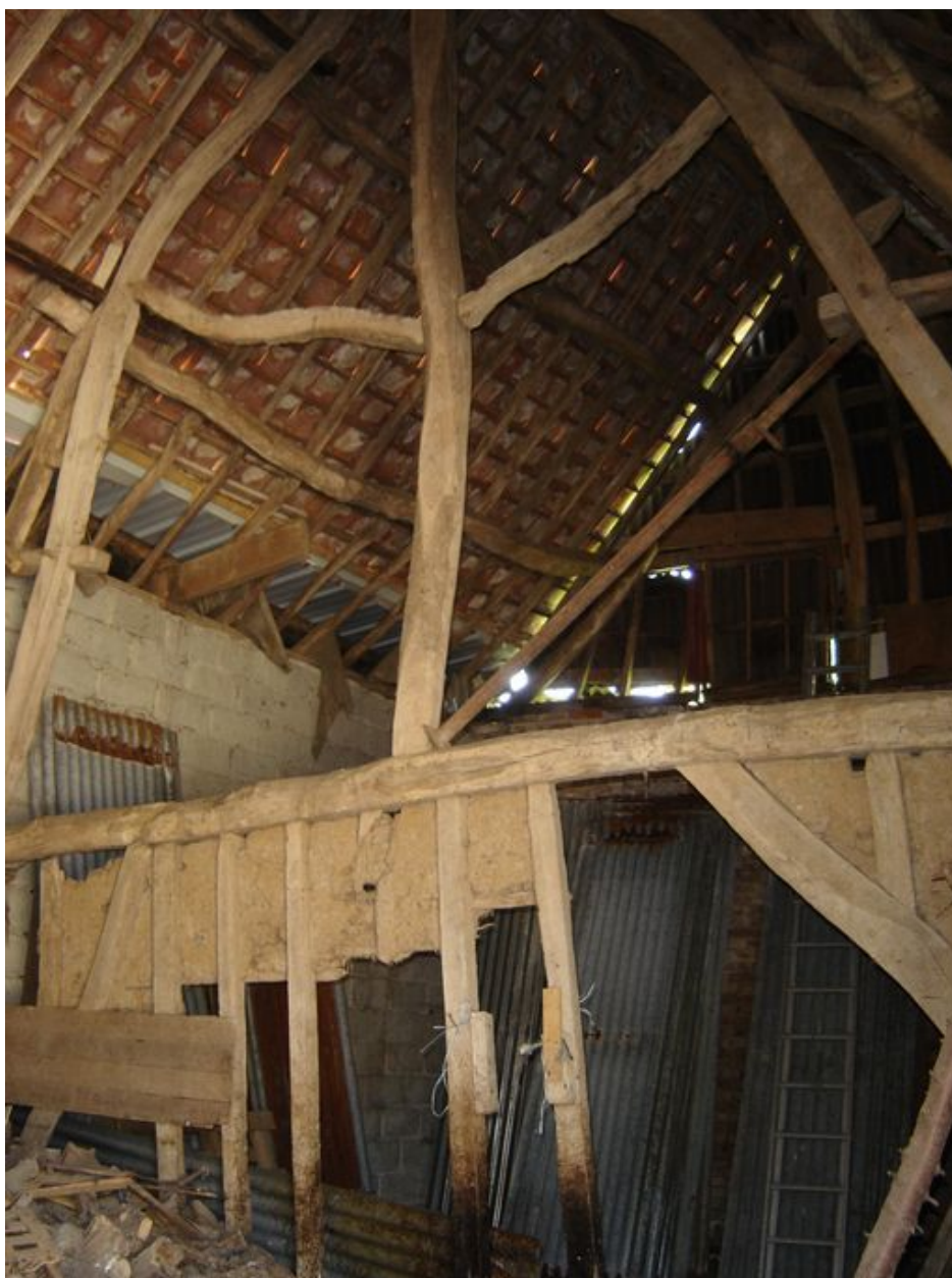
Vue intérieure des cloisons de la grange.
