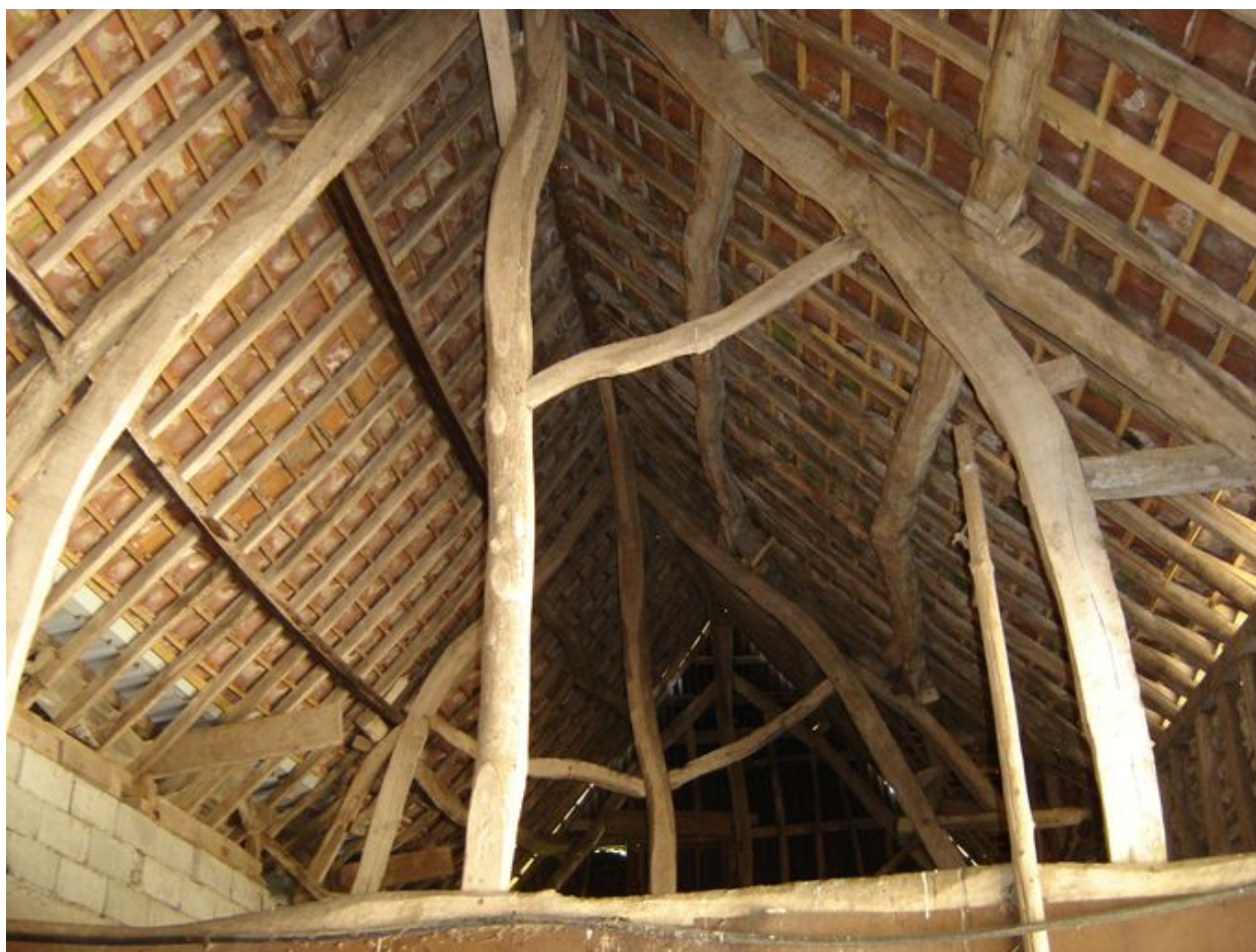
Vue de la charpente de la grange.
