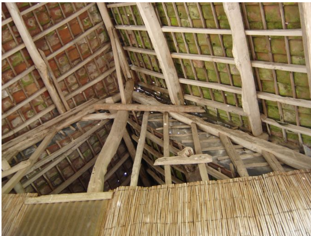
Vue de la charpente du passage couvert.
