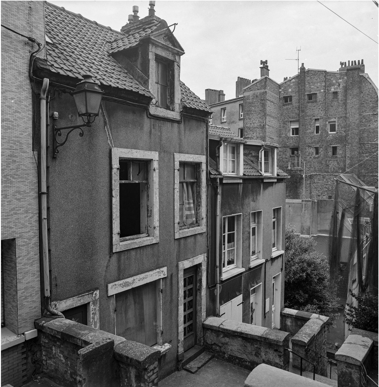
Vue générale de la voie.
