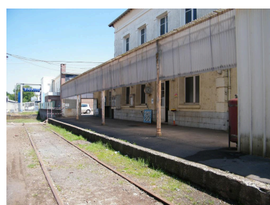
Gare avant destruction définitive (2015), vue de la façade sur les quais. Phot. Bouvet Hubert (reproduction) IVR32_20196200969NUC1A
