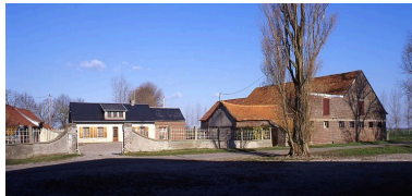
Vue générale. Phot. Irwin Leullier IVR22_20078000092NUC1A
