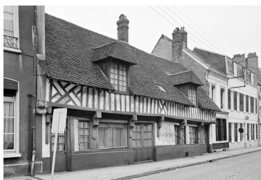
L'Âne rayé et Le Petit-Écu. Façade sur rue (1981). Phot. Jean-Michel Périn IVR31_19816201115X
