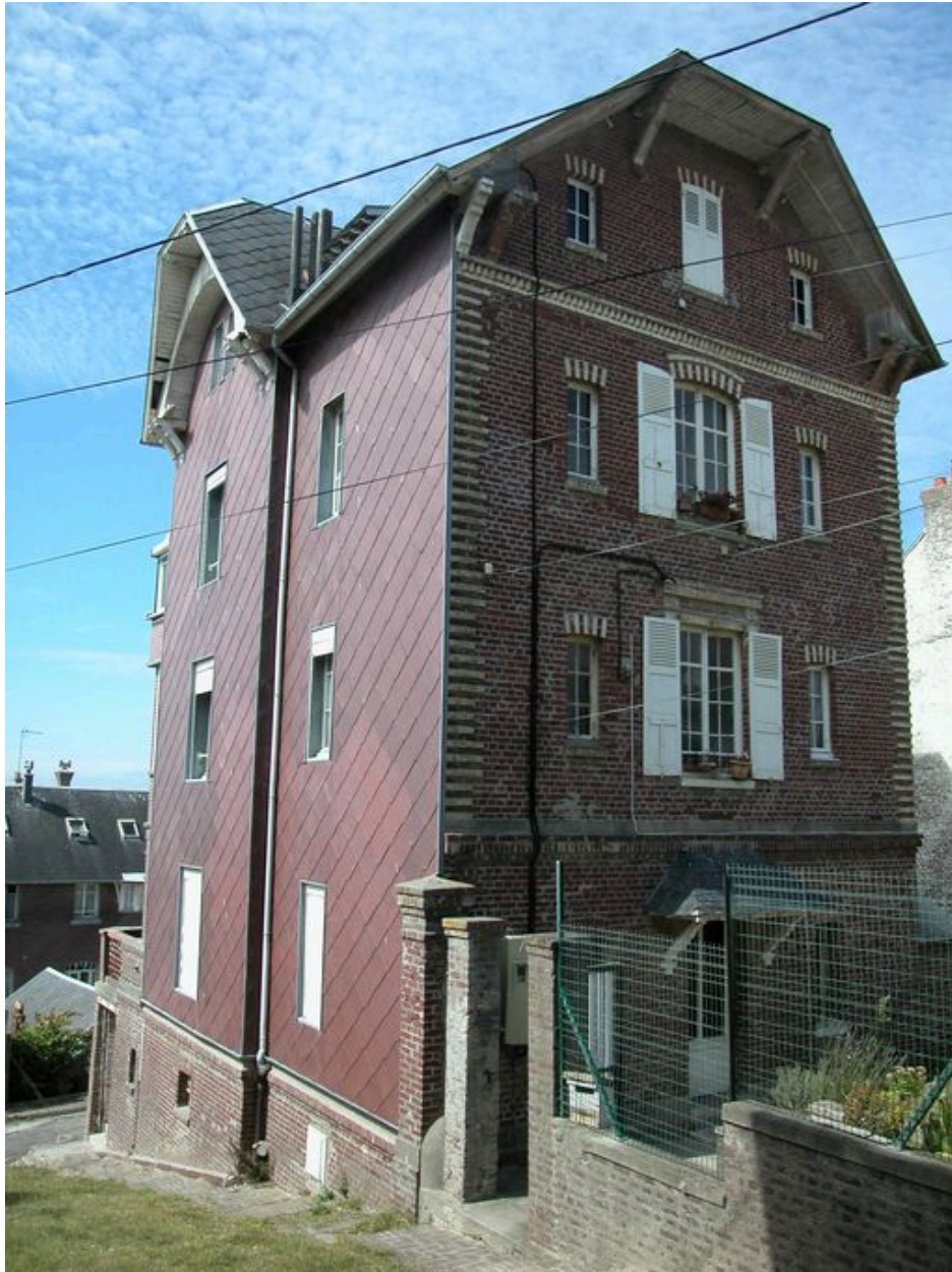
Vue de trois-quarts depuis le sud, façade postérieure et façade latérale essentée en ardoises.
