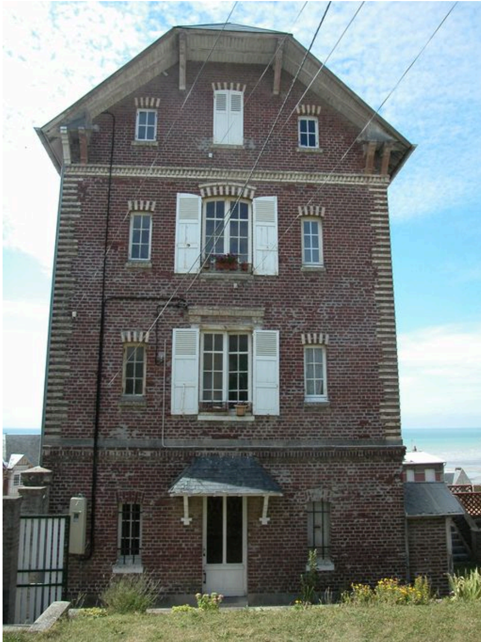
Elévation sur la rue Gros, façade postérieure d'entrée.
