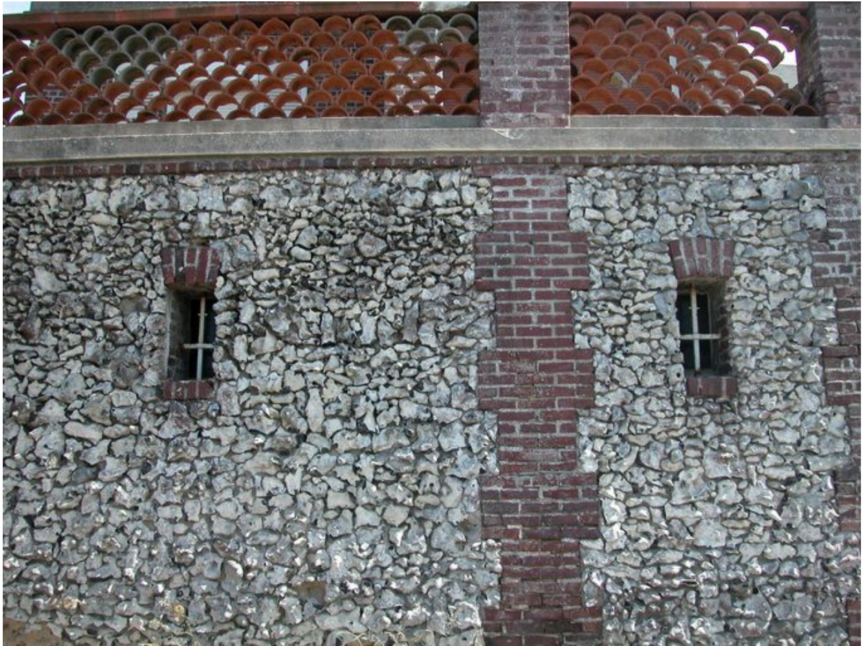
Détail du mur de soutènement, rue des Architectes.
