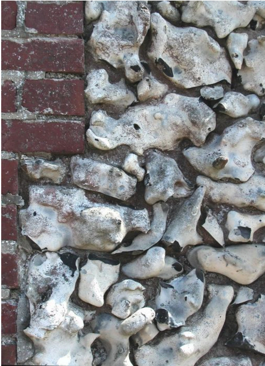
Détail des moellons de silex du mur de soutènement.
