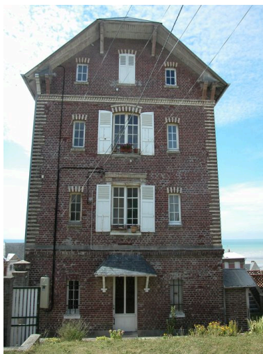
Élévation sur la rue Gros, façade postérieure d'entrée. Phot. Elisabeth Justome IVR22_20048001541NUCA
