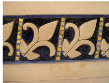
L'autel du bas-côté ouest : détail sur le décor de faïence. Phot. Isabelle Barbedor IVR22_20038010357NUCA
