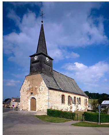
Façade occidentale, vue depuis le sud-est. Phot. Laurent Jumel IVR22_19970200969VA
