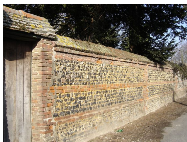
Vue du mur de clôture dans la rue Jacquot. Phot. Inès Guérin IVR22_20058005056NUCA
