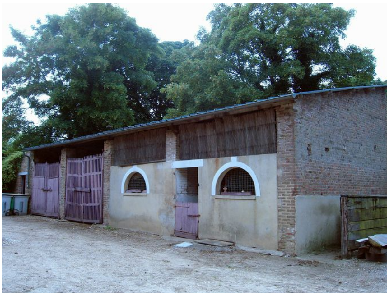
Vue de l'abri à voitures.
