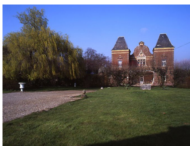
Vue générale de la ferme. Phot. Irwin Leullier IVR22_20078000033XA
