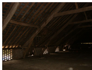
Vue détaillée de ces aérations. Phot. Inès Guérin IVR22_20058006011NUCA
