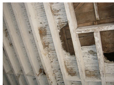
Détail du plafond des écuries composé de torchis enroulé autour de lattes. Phot. Inès Guérin IVR22_20058006006NUCA
