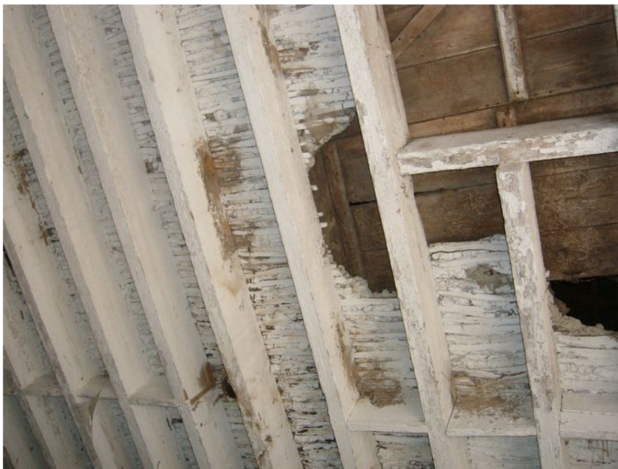
Détail du plafond des écuries composé de torchis enroulé autour de lattes.
