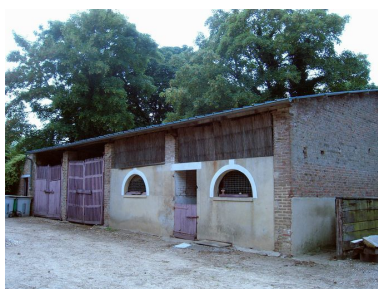
Vue de l'abri à voitures.
