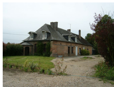
Vue postérieure des bâtiments sur rue. Phot. Inès Guérin IVR22_20058005996NUCA
