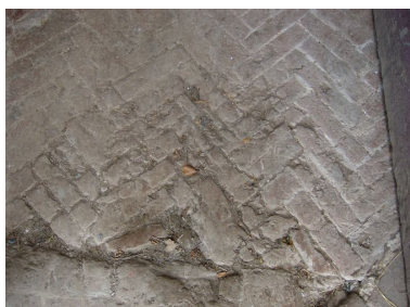
Vue du sol des écuries. Phot. Inès Guérin IVR22_20058006005NUCA
