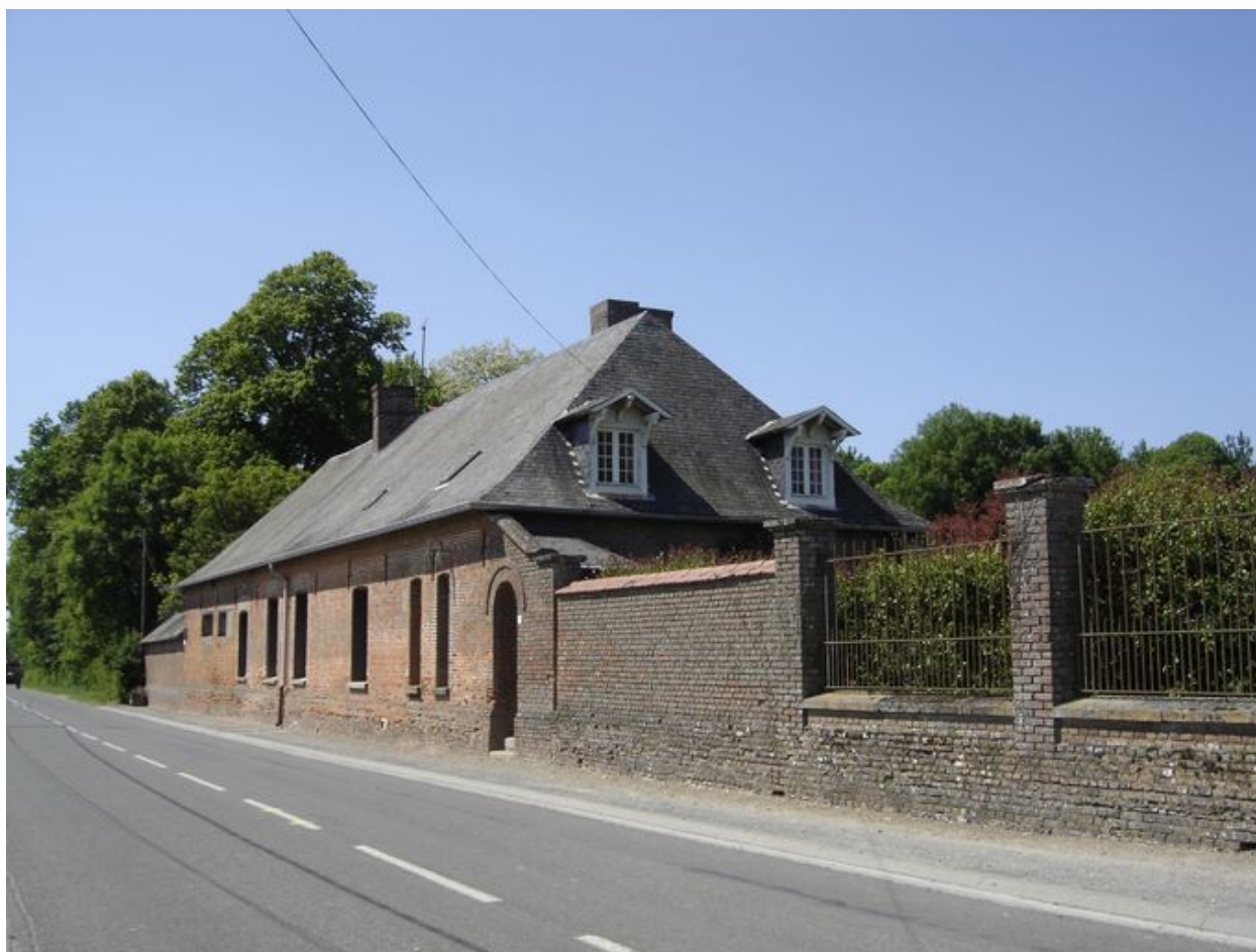
Vue des bâtiments sur rue.
