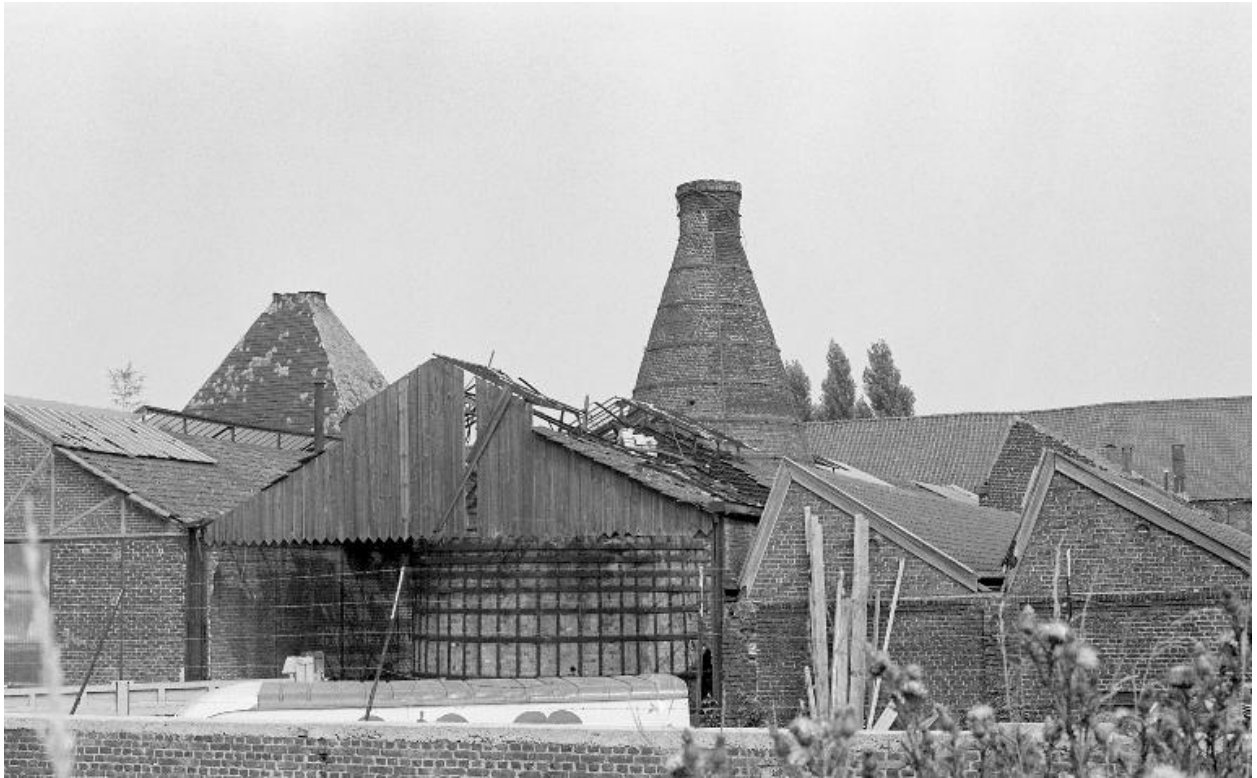
Manufacture de Faïences et Porcelaines du Moulin-des-Loups, vue générale en 1981 du bâtiment abritant les fours (Cliché MH Drac NpdC).
