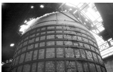
Manufacture de Faïences et Porcelaines du Moulin-des- Loups, vue générale du four en 1981 (Cliché MH Drac NpdC). IVR31_19815913314NUC
