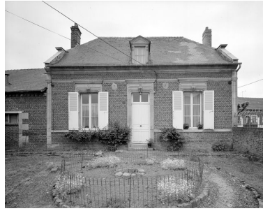
Elévation antérieure. Phot. Jean-Michel Perrin IVR22_19856000839V
