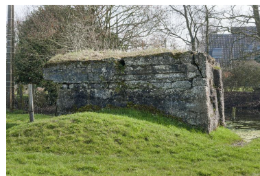
Elévation nord Phot. Jean-Marc Ramette IVR31_20145905524NUCA
