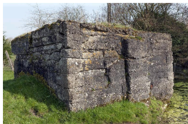
Vue de trois-quarts vers le sud-est Phot. Jean-Marc Ramette IVR31_20145905529NUCA
