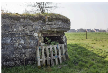
Porte sur l'angle nord-est Phot. Jean-Marc Ramette IVR31_20145905528NUCA
