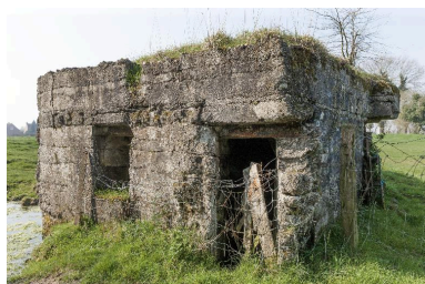
Elévatiion sud Phot. Jean-Marc Ramette IVR31_20145905525NUCA
