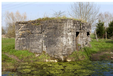
Vue de trois-quarts vers le nord-est Phot. Jean-Marc Ramette IVR31_20145905523NUCA
