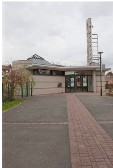
Elévation postérieure. Phot. Pierre Thibaut IVR31_20145903140NUCA
