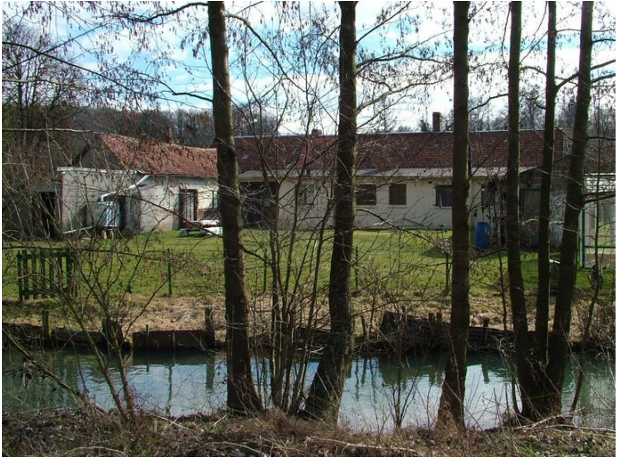
Vue générale depuis la rivière.
