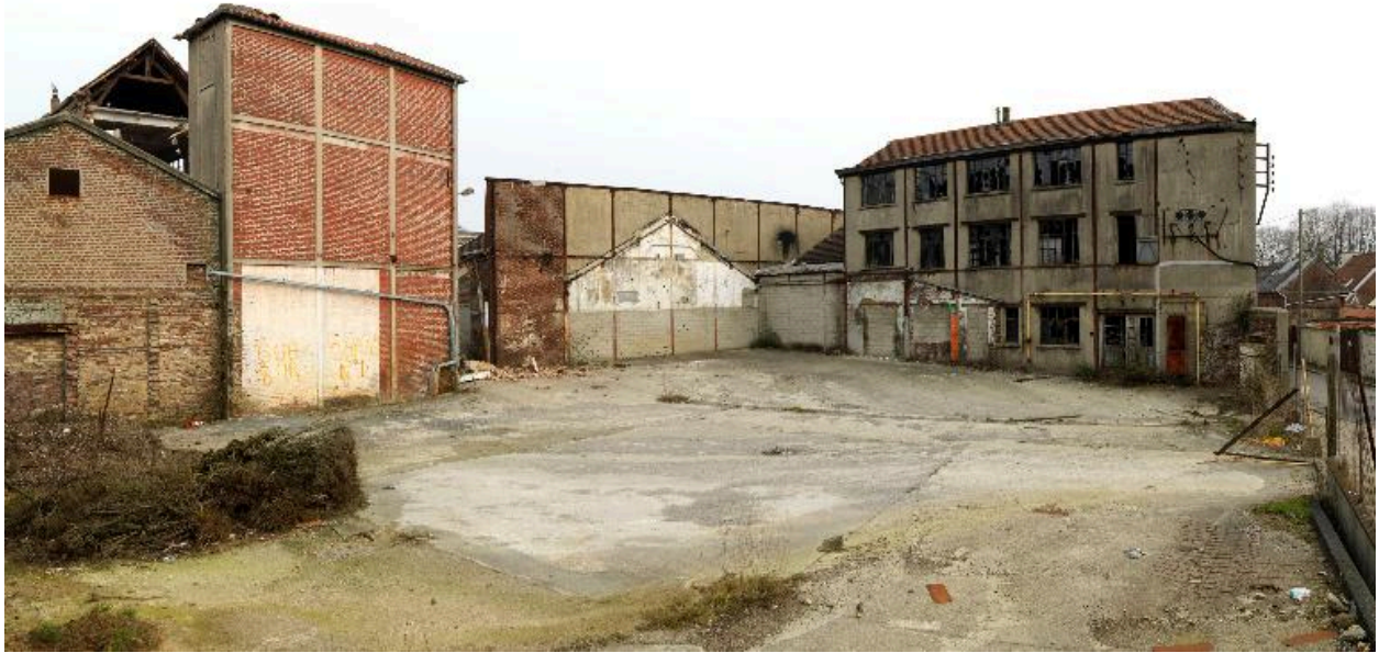
Vue générale depuis le sud.
