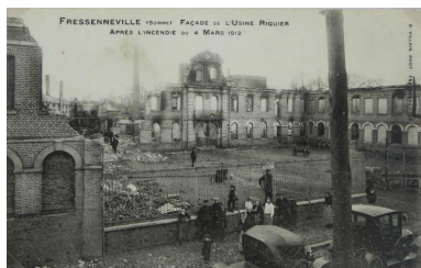
L'ancienne usine après l'incendie de 1912 (coll. part.). Phot. Romain Grimaud (reproduction) IVR22_20128005182NUC2A
