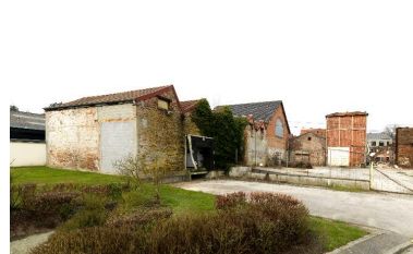
Atelier de fabrication, flanc nord, depuis la rue Karl-Marx. Phot. Thierry Lefébure IVR22_2013800006NUC2AQ
