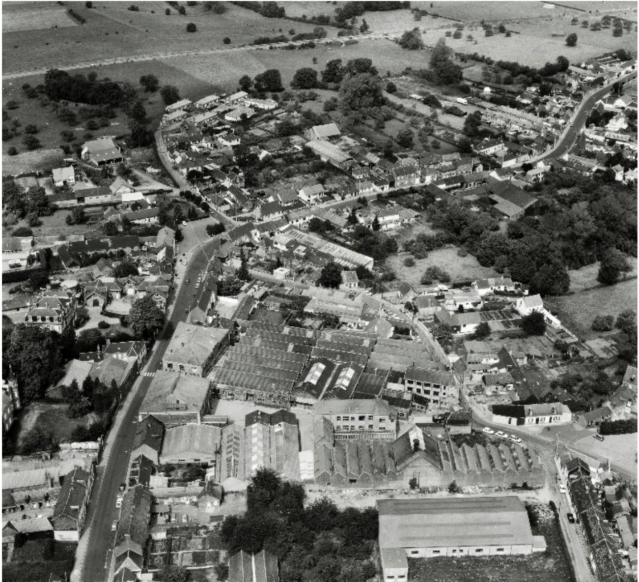
Vue aérienne de l'usine depuis le sud, 1988.
