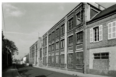
Façades de l'usine, rue Roger-Salengro, en 1988.
