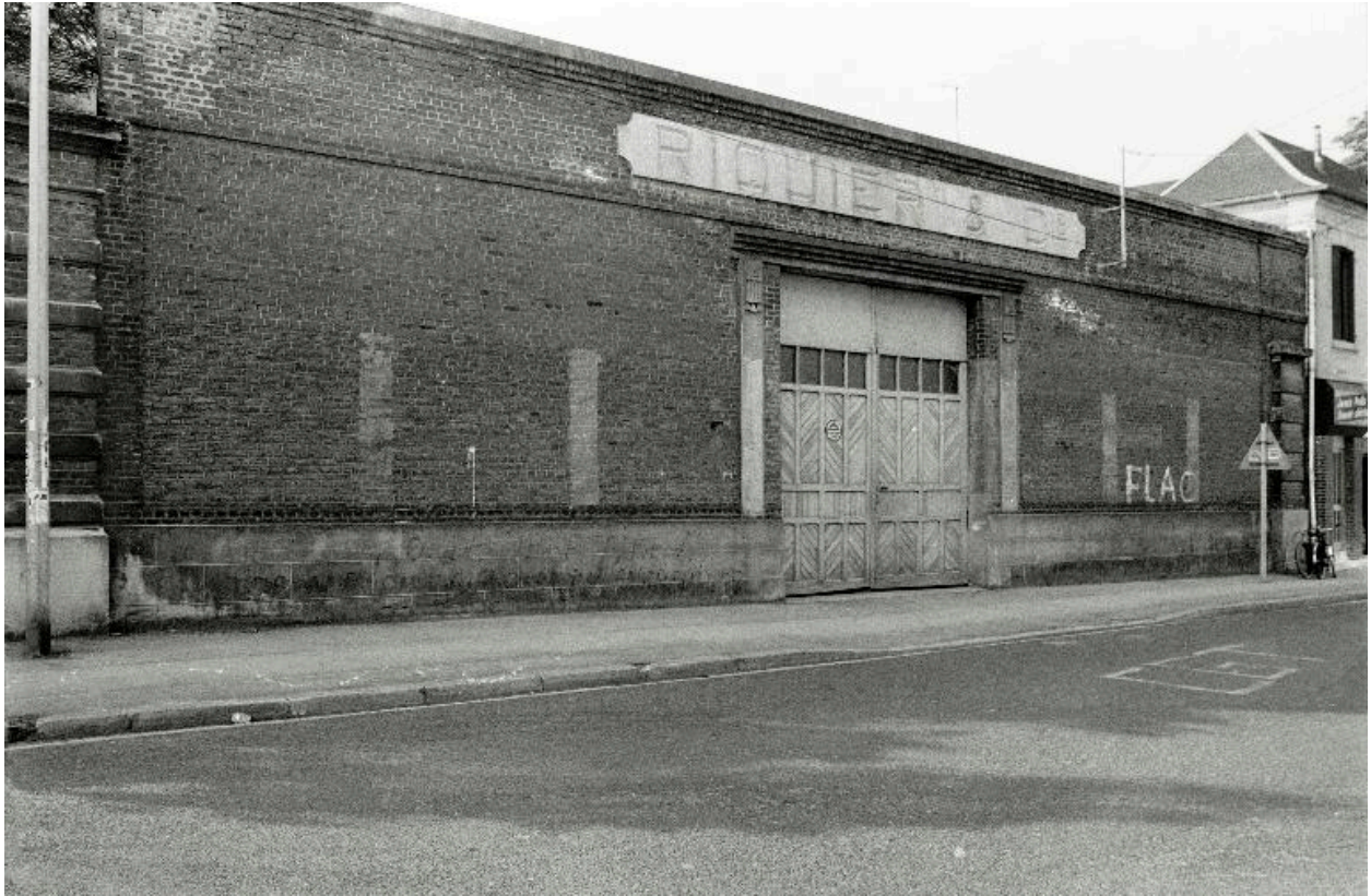
L'entrepôt, rue Roger-Salengro, en 1988.
