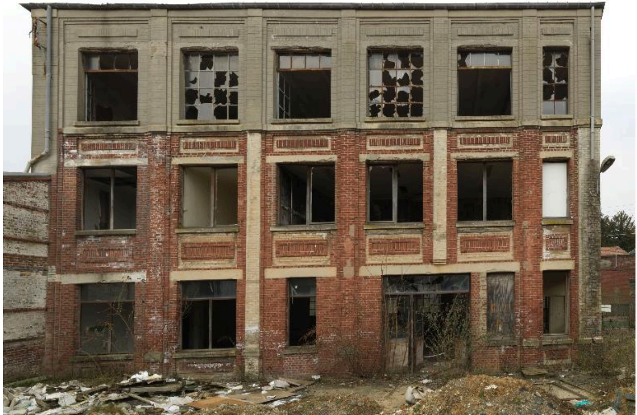
Façade postérieure du bâtiment principal sud.
