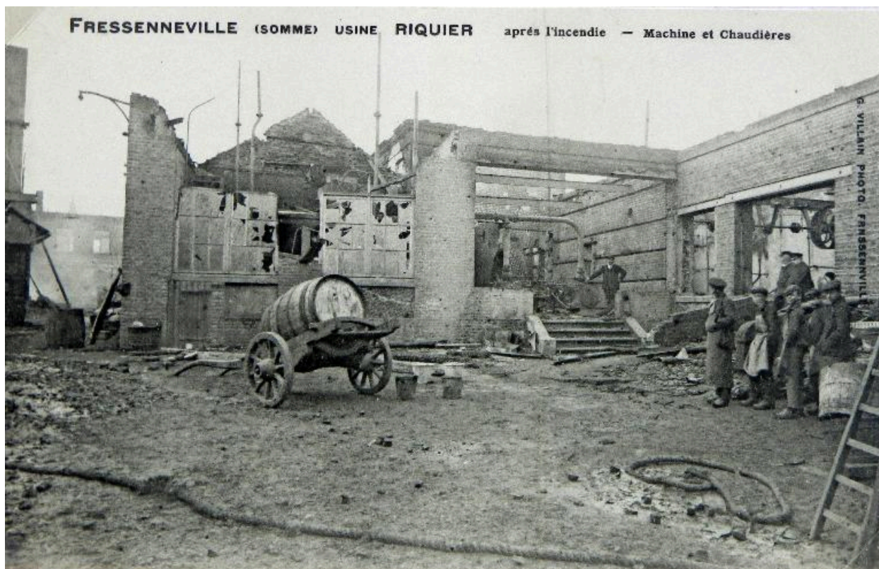
La salle des machines après l'incendie de 1912 (coll. part.).
