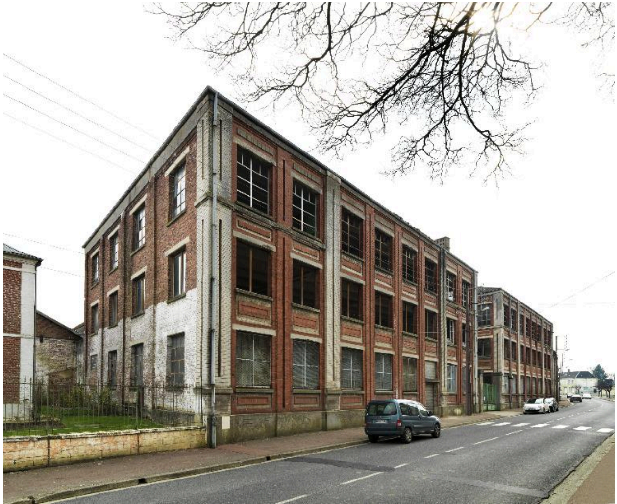
Vue générale depuis le nord, rue Roger-Salengro.
