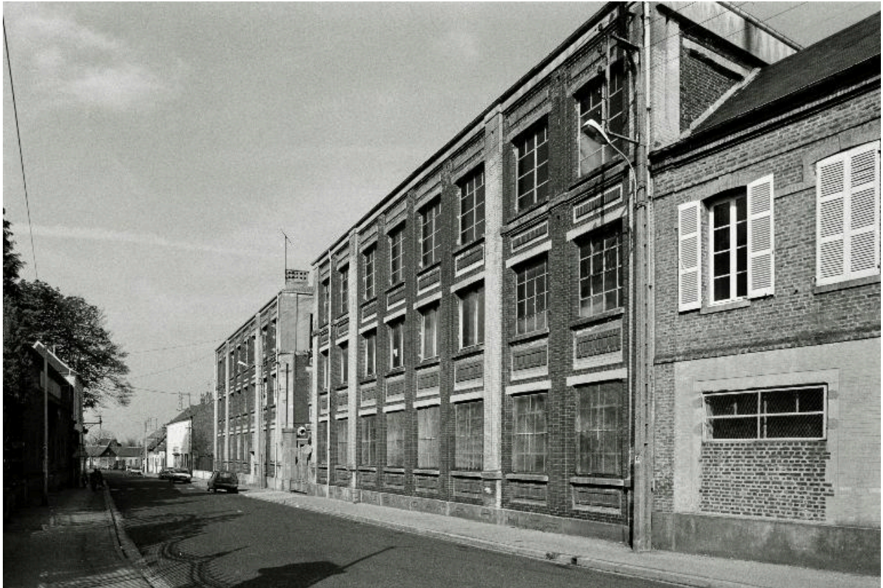
Façades de l'usine, rue Roger-Salengro, en 1988.
