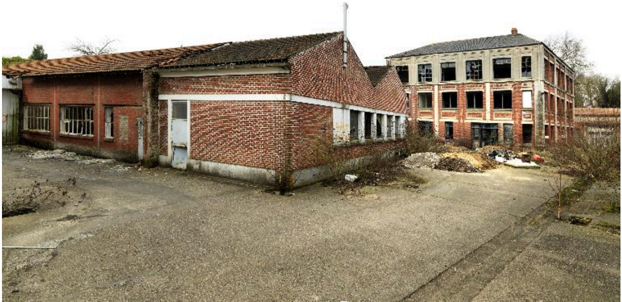
Vue d'ensemble du sud du site industriel.
