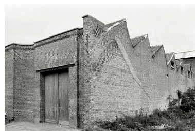
Atelier de fabrication, flanc sud, en 1990.
