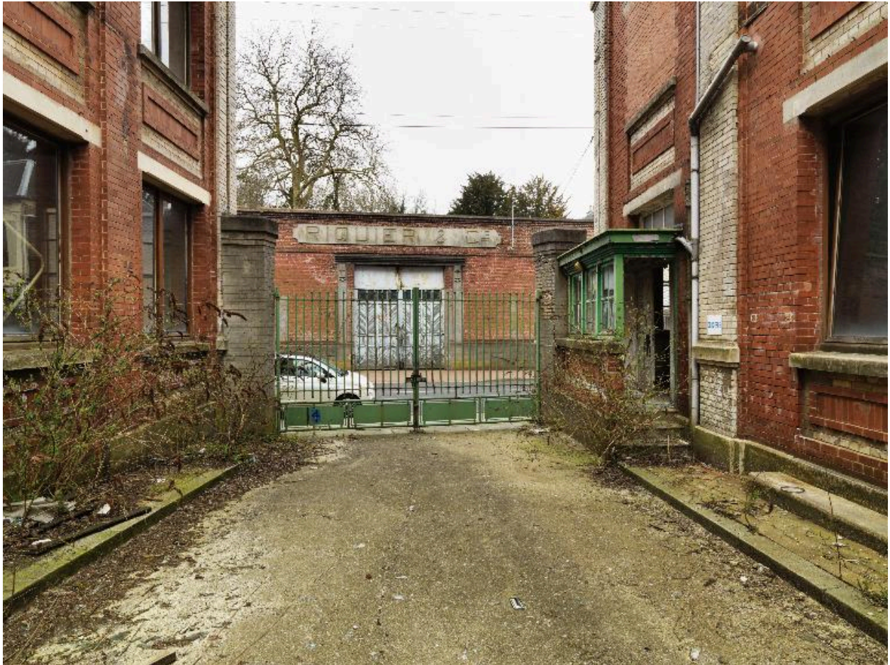
L'entrée principale depuis l'intérieur de la cour, le magasin de la rue Roger-Salengro à l'arrière-plan.
