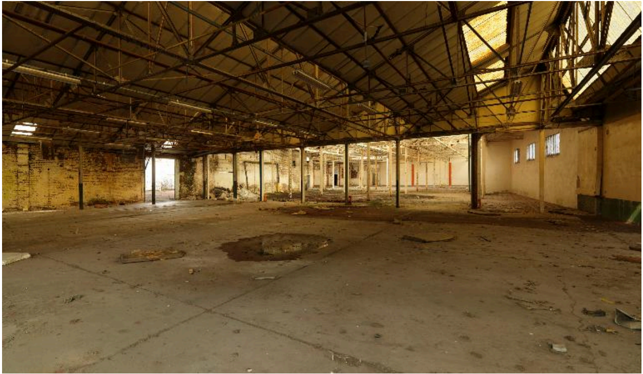
Vue intérieure des anciens ateliers de préparation.
