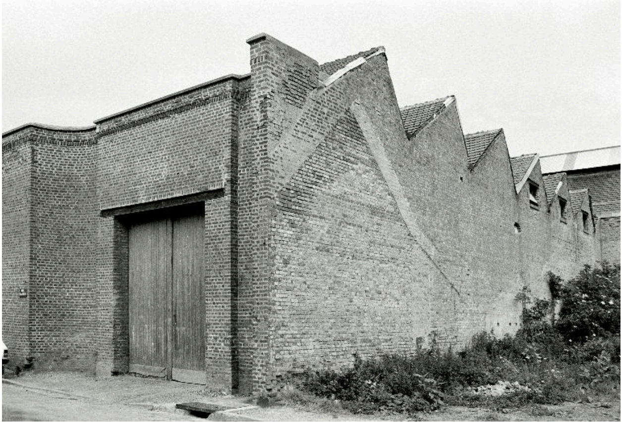
Atelier de fabrication, flanc sud, en 1990.
