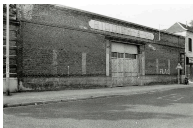
L'entrepôt, rue Roger-Salengro, en 1988.
