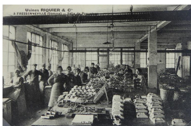
Atelier de paquetage de la nouvelle usine, carte postale, vers 1920 (coll.part.). Phot. Romain Grimaud (reproduction) IVR22_20128005179NUC2A
