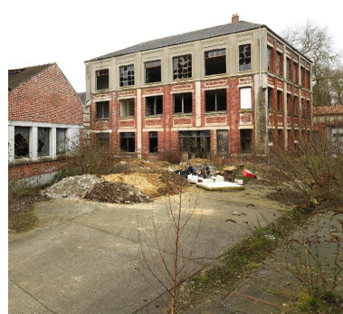
Vue de la façade postérieure du bâtiment principal sud. Phot. Thierry Lefébure IVR22_2013800012NUC2A
