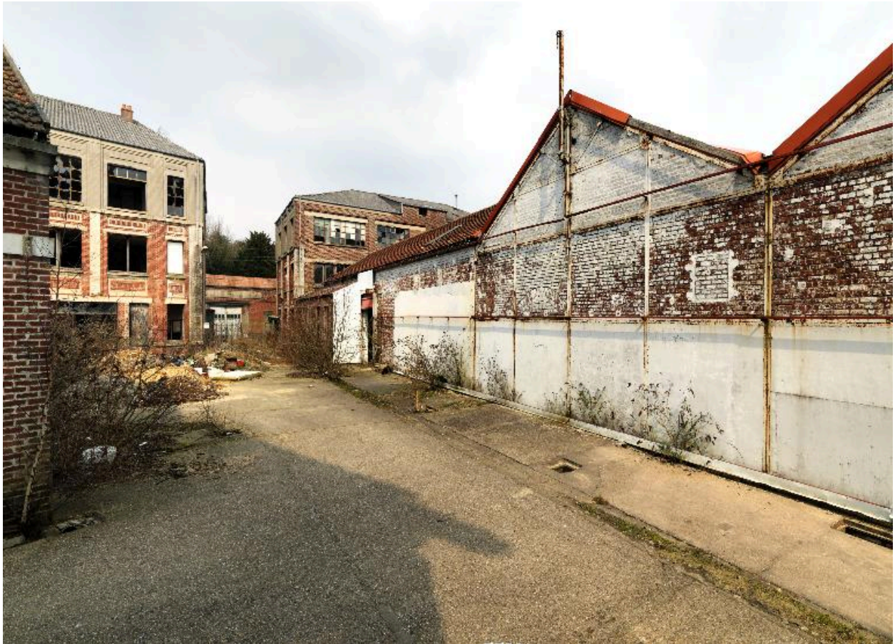
Vue d'ensemble du nord du site industriel.
