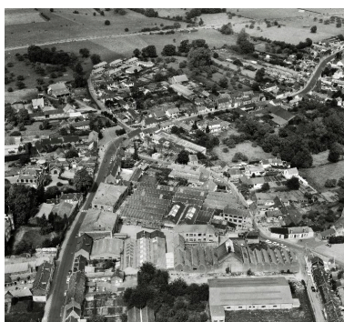
Vue aérienne de l'usine depuis le sud, 1988.
