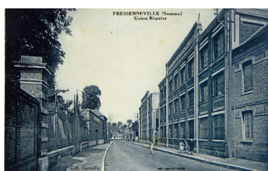
La façade principale de l'usine Riquier et les grilles de la maison patronale, vers 1920 (coll. part.). Phot. Romain Grimaud (reproduction) IVR22_20128005190NUC2A
