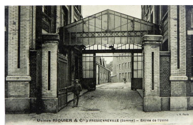
Entrée de la nouvelle usine, vers 1920 (coll. part.). Phot. Romain Grimaud (reproduction) IVR22_20128005187NUC1A
