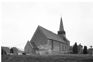
Vue générale depuis le nord-est. Phot. Thierry Lefébure IVR22_19930200612V
