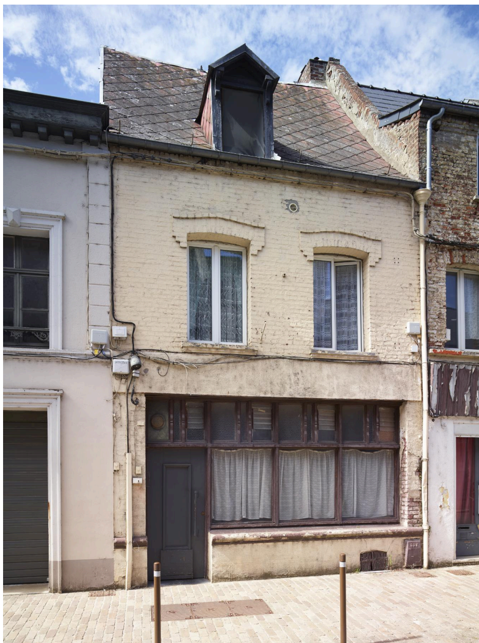
Maison datée du 3ème quart du XIXe siècle, avec chambranles à crossettes partiels entièrement en briques - 7, rue Weibel.
