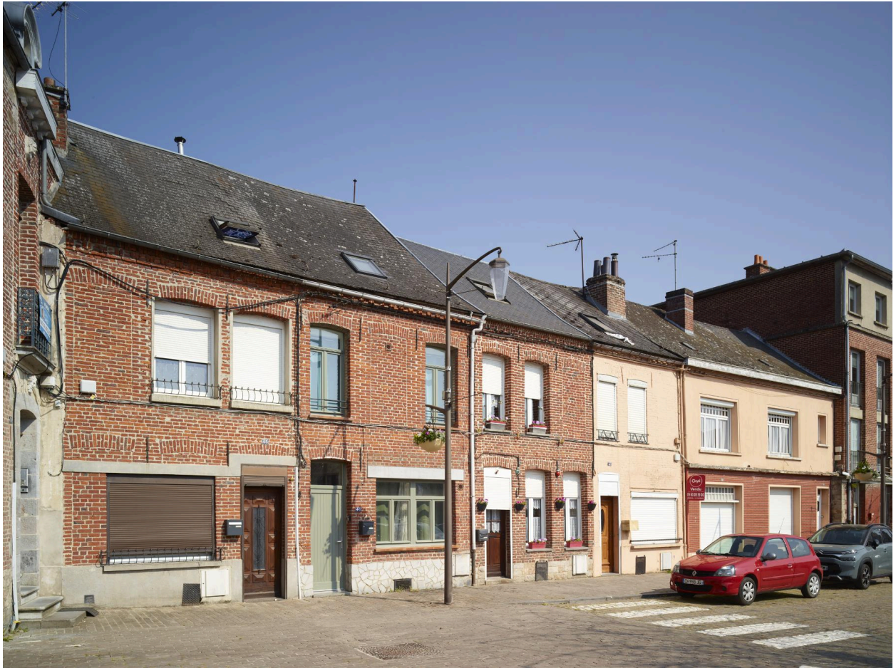
Rang construit au XIXe siècle à l'extrémité de la place Leclerc : façade du n°36 reprise lors de la Seconde Reconstruction, visible à la forme horizontale des baies.
