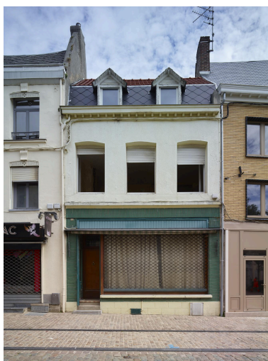
Maison à boutique datée du XVIIIe siècle : vitrine en applique du XIXe siècle, cadre en briques émaillées - 44, rue Joffre. Phot. Pierre Thibaut IVR32_20245900024NUCA
