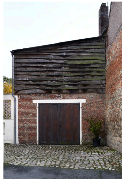
Garage dont la partie haute est couverte à clins - 13, rue Brancion. Phot. Delphine Volto Jourdan IVR32_20255901421NUCA
