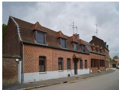
Maisons d'un seul niveau avec combles - troisième quart XIXe siècle - 6 et 8, rue de Turenne. Phot. Pierre Thibaut IVR32_20245900212NUCA
