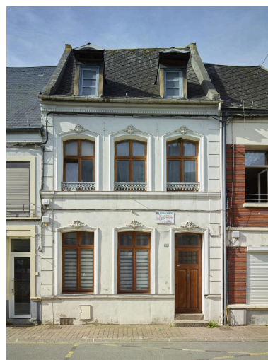
Maison à trois travées, avec un nombre identique de baies aux deux niveaux de façade, pignons latéraux débordants et lucarnes capucines, 3ème quart XVIIIe siècle - 21, rue Gambetta. Phot. Pierre Thibaut IVR32_20245900845NUCA
