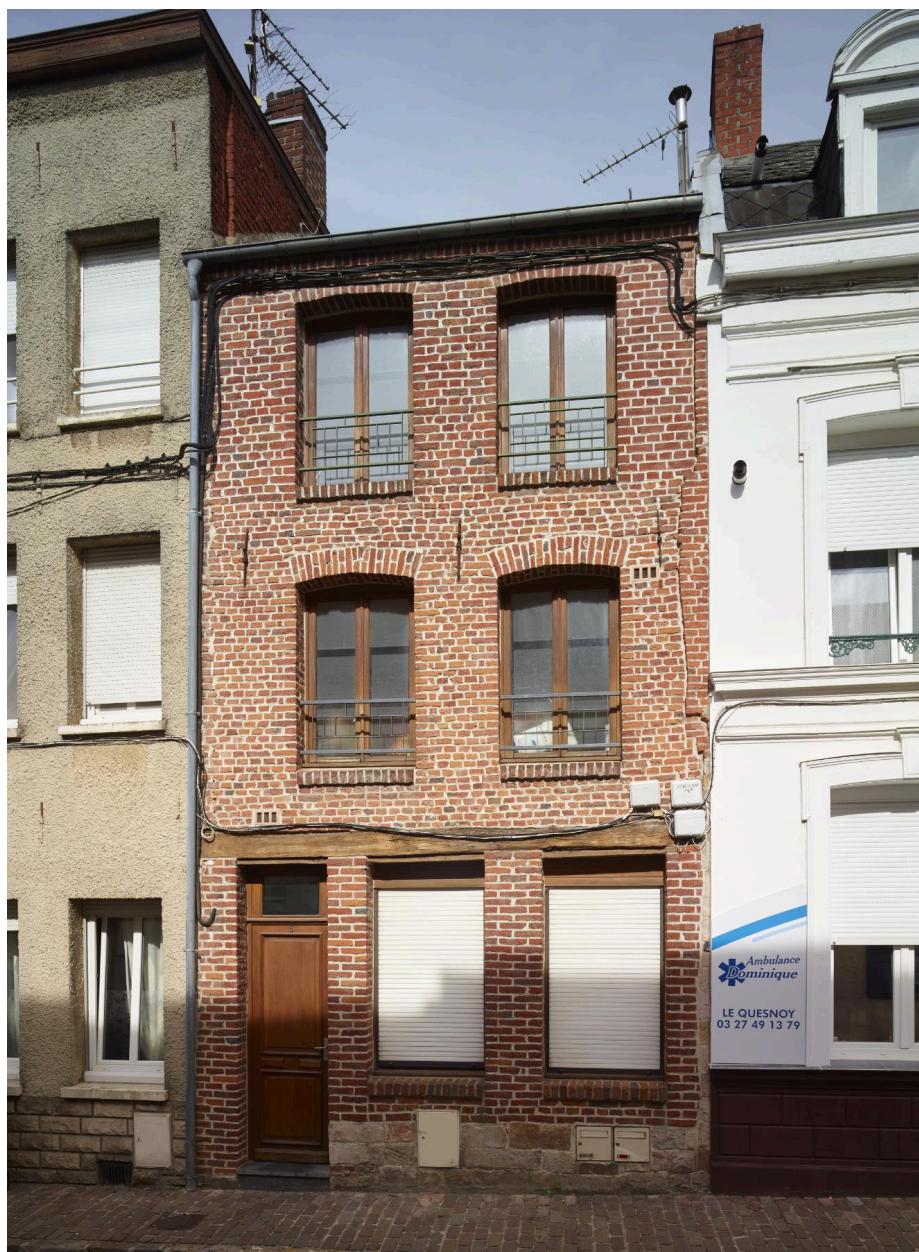
Maison de trois niveaux du début du XVIIIe siècle - 5, rue Jean-Jaurès. La maison présente également un nombre de baies différent entre les niveaux, mais une composition symétrique axiale.
