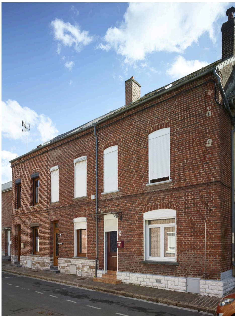
Exemple de maisons groupées du 1er quart du XIXe siècle - 27-31, rue Saint-François.
