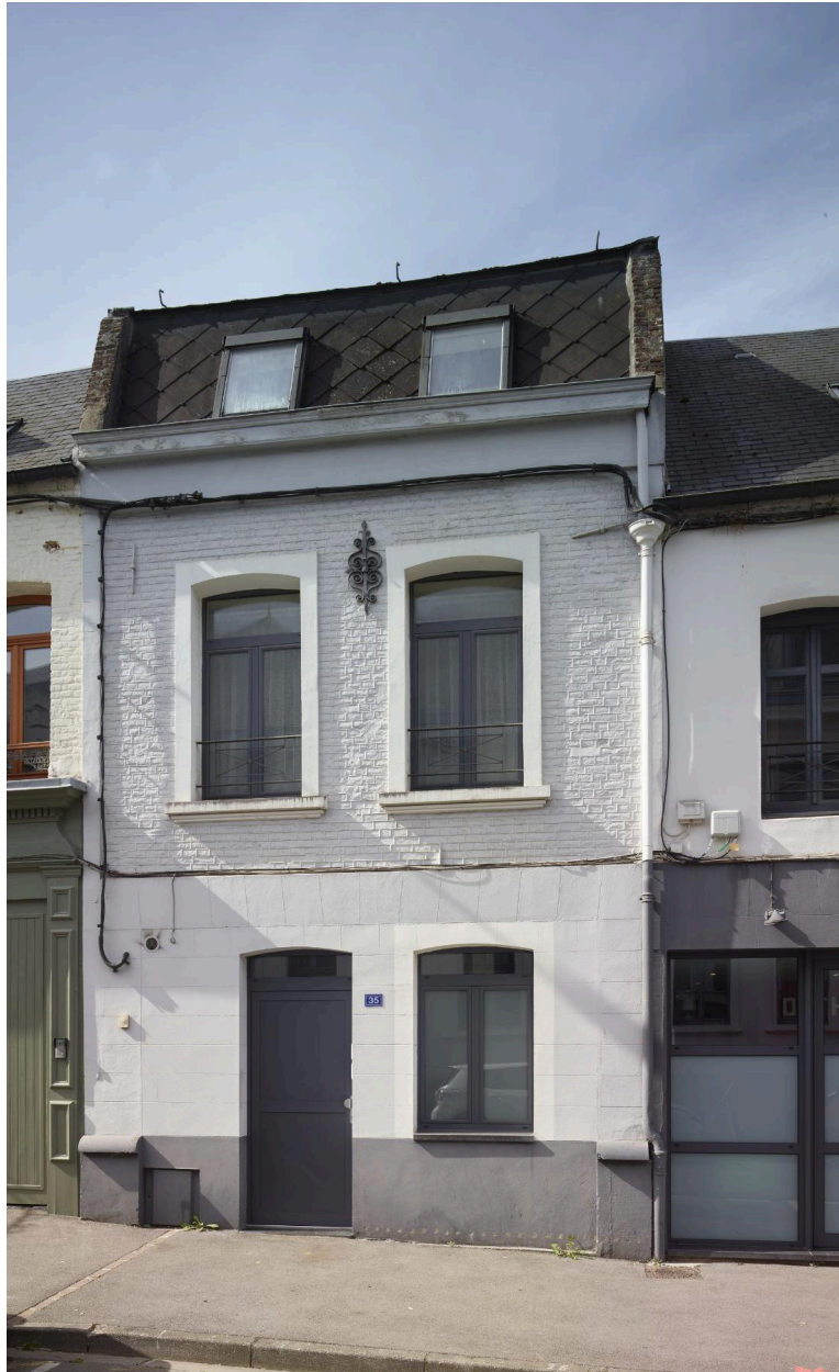
Maison, première moitié du XVIIIe siècle : pignons débordants et toiture brisée s'achevant par un cheneau, premier niveau recouvert d'un enduit posé en bossage plat continu et second niveau simplement badigeonné, fer d'ancrage ouvragé - 35, rue Thiers.
