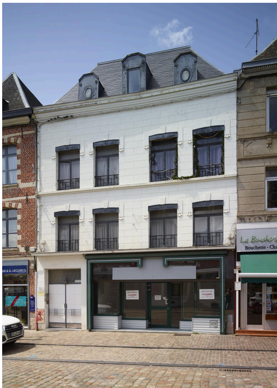
Maison - 8 place du Général-Leclerc : exemple de façade du XVIIIe siècle avec façade modernisée dans la seconde moitié du XXe siècle.
