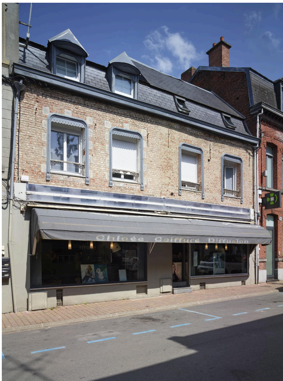
Maison à boutique - 8, rue Gambetta : exemple de bâti XVIIIe siècle sur lequel est venu se greffer une vitrine en applique du XXe siècle.
