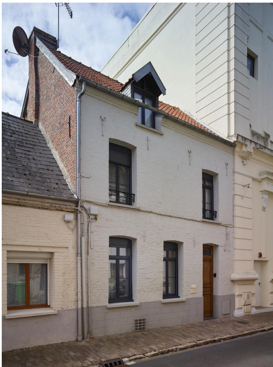
Maison du XVIII e siècle présentant une façade avec une symétrie axiale mais un nombre différent de baies aux deux niveaux, la porte étant située à gauche - 9, rue Valory.
