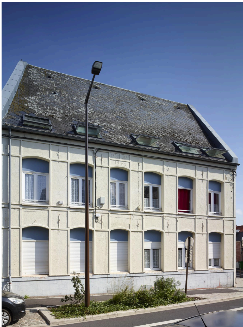
Ancien orphelinat construit entre 1925 et 1936 : partie est de la façade rue de la Nouvelle-Zélande, vue orientée est-ouest.
