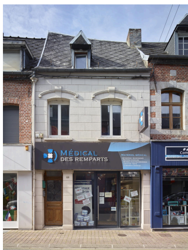
Maison XVIIIe siècle : partie haute enduite en faux appareil, baies sans chambranle surmontées d'une archivolte moulurée s'achevant par des volutes sur laquelle vient brocher une agrafe en forme de console décorée de glyphes - 7, rue Gambetta. Phot. Pierre Thibaut IVR32_20245900838NUCA
