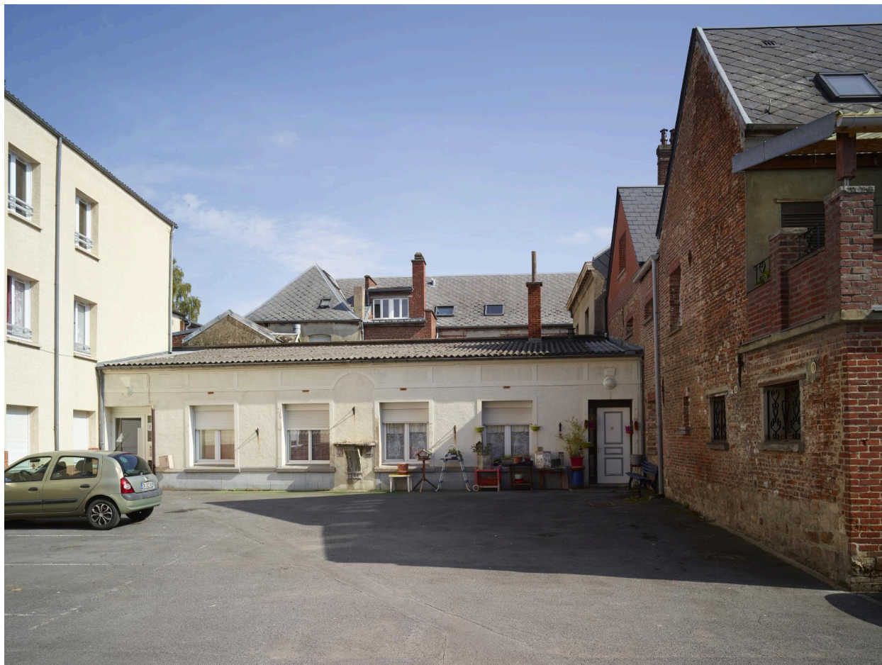
Maison, rue Carlier : exemple d'insertion dans un bâti du XXe siècle (date portée de 1941 dans le bandeau au-dessus de la fontaine) d'une pierre portant la date de 1556 (au-dessus de la porte d'entrée droite).
