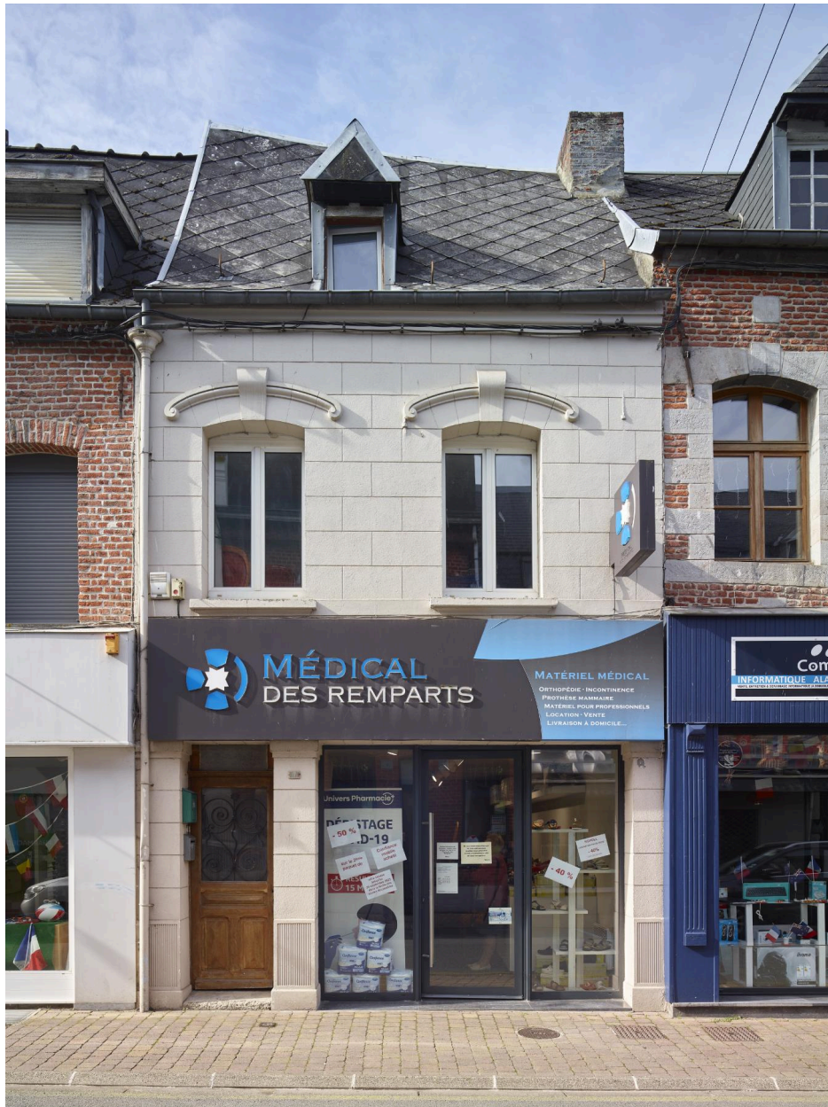
Maison XVIII e siècle : partie haute enduite en faux appareil, baies sans chambranle surmontées d'une archivolte moulurée s'achevant par des volutes sur laquelle vient brocher une agrafe en forme de console décorée de glyphes - 7, rue Gambetta.
