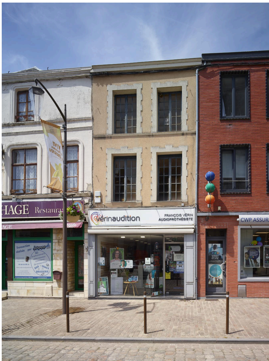
Maison, début du XIXe siècle : ensemble du chambranle réalisé en enduit lisse imitant une chaîne harpée - 6, rue Fournier.
