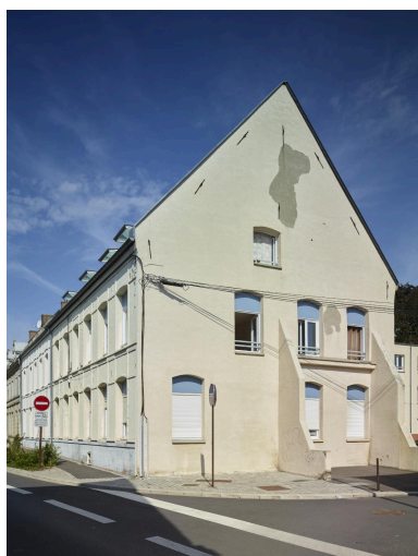
Ancien orphelinat construit entre 1925 et 1936 - angle des rues Carlier et de la Nouvelle-Zélande : vue du pignon.
