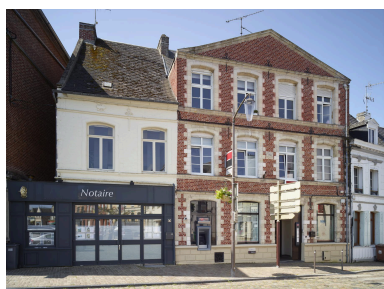
Maison - 28, place Leclerc : exemple de maison du XVIIIe siècle reprise et modifiée lors de la Première Reconstruction. Phot. Pierre Thibaut IVR32_20235901080NUCA
