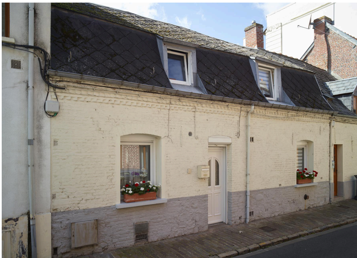
Maison - 5, rue Valory : exemple de maison en rez-de-chaussée avec un niveau de combles.
