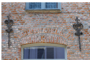
Fer d'ancrage à volutes inversées, pointe fleurdelisée, base décorée de symboles mathématiques, feuille nervurée sur le nœud sur une maison datée de la seconde moitié du XVIIIe siècle - 7, rue Chevray. Phot. Pierre Thibaut IVR32_20255900272NUCA
