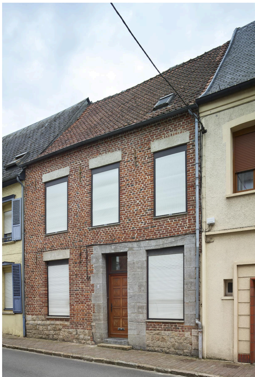
Maison, XVIIe siècle : soubassement en grès et rare entourage de la totalité des baies en pierre bleue, trois travées avec la porte au centre - 4, rue Jean-Jaurès.
