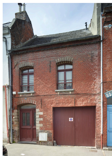
Maison datée de la fin du XVIIIe siècle : soubassement en grès, chaîne harpée en calcaire pour la porte, arc des baies faisant alterner briques rouges ou peintes en blanc, fer d'ancrage simple avec juste une feuille sur le nœud - 29, rue Thiers. Phot. Pierre Thibaut IVR32_20245900812NUCA
