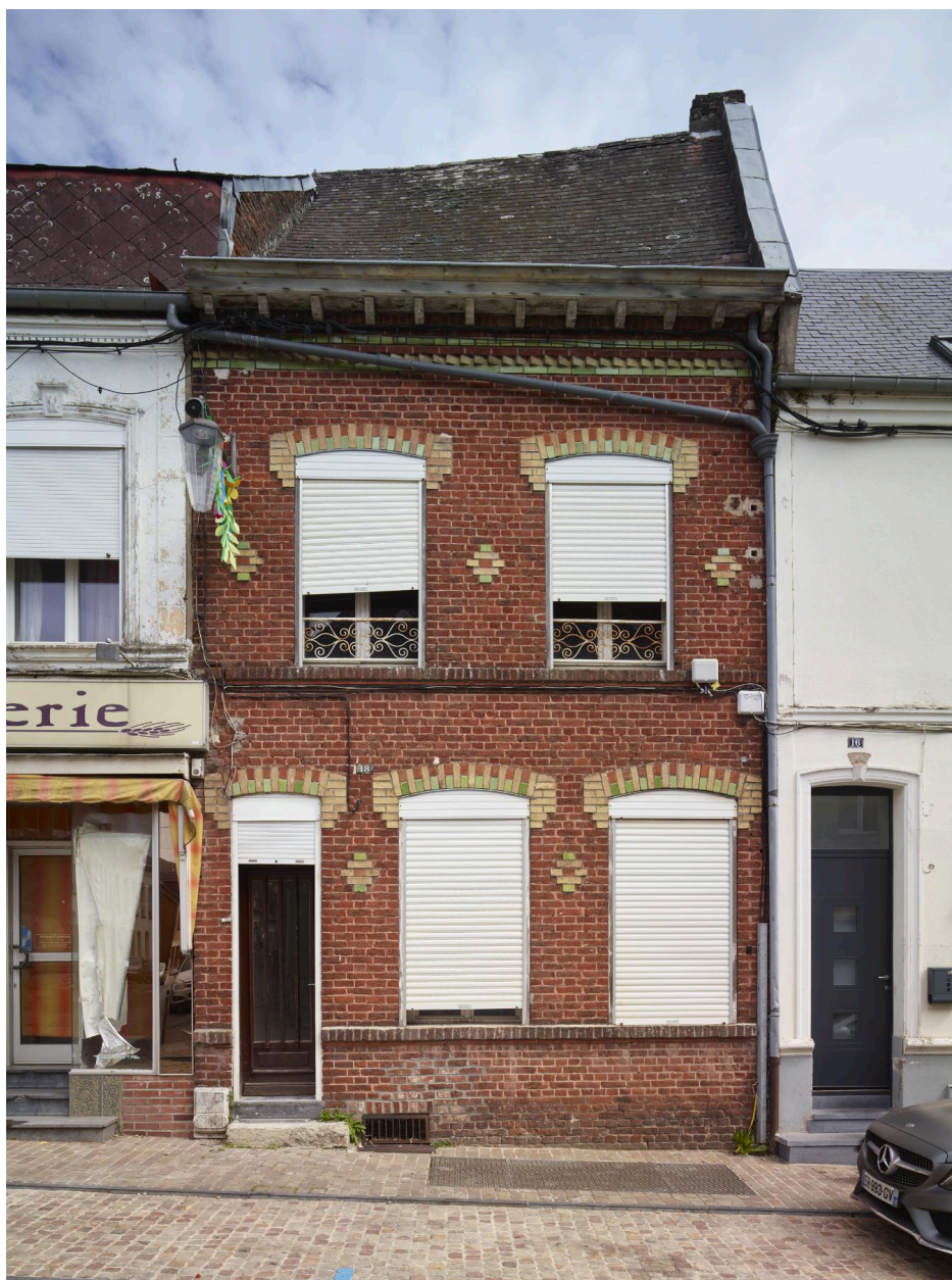
Maison - 18, rue Joffre : maison du XVIIIe siècle, organisation, forme de ses baies, toiture très pentue d'origine. Ajout de briques émaillées fin du XIXe siècle sur la façade.
