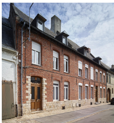
Maisons jumelles de la seconde moitié du XVIIIe siècle, avec chaînes harpées en grès limitées aux pieds-droits - 4 et 6, rue de la Couronne.
