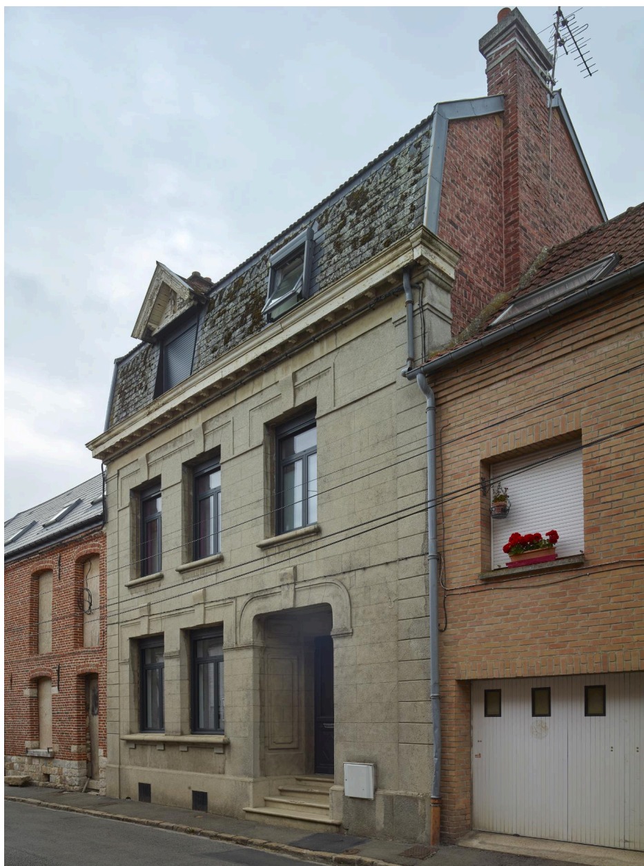
Maison du XVIII e siècle, modifiée dans la première moitié du XX e siècle, avec degré encagé en retrait par rapport au nu du mur, trois travées et porte située à droite - 26, rue Carlier.
