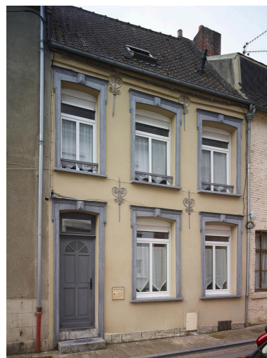
Maison datée du XVIIIe siècle, avec trois travées et porte à gauche, et baies entourées d'un chambranle plaqué en bois mouluré et à crossettes, interrompu par une agrafe en pointe de diamant ; fers d'ancrage décorés de volutes doubles avec tige portant un motif de croix et barrettes à la base et une feuille de chêne sur le nœud - 11, rue de la Couronne. Phot. Pierre Thibaut IVR32_20245900325NUCA
