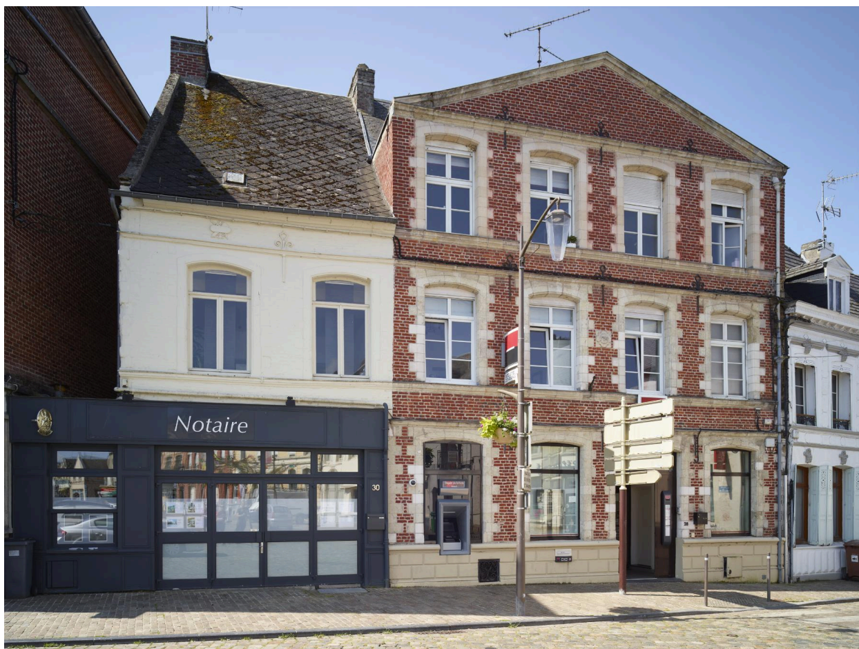
Maison - 28, place Leclerc : exemple de maison du XVIIIe siècle reprise et modifiée lors de la Première Reconstruction.
