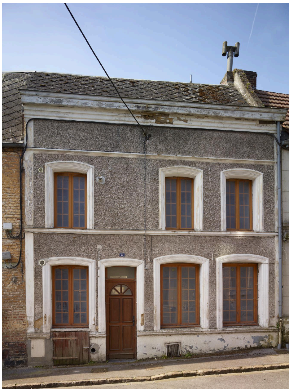
Maison de la fin du XVIIIe siècle présentant une façade rythmée malgré un nombre différent de baies aux deux niveaux (4 et 3), la partie au-dessus de la porte étant occupée par un mur plein - 5, rue des Lombards.
