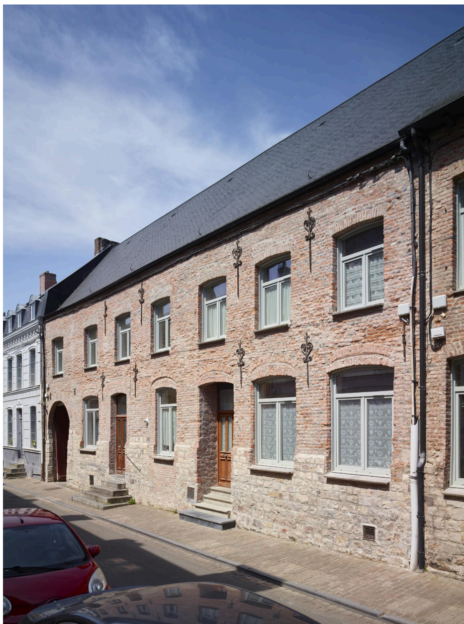
Maisons groupées du XVIIIe siècle - 7-7 bis, rue Chevray. Construites sur un soubassement en grès, elles présentent un degré important.
