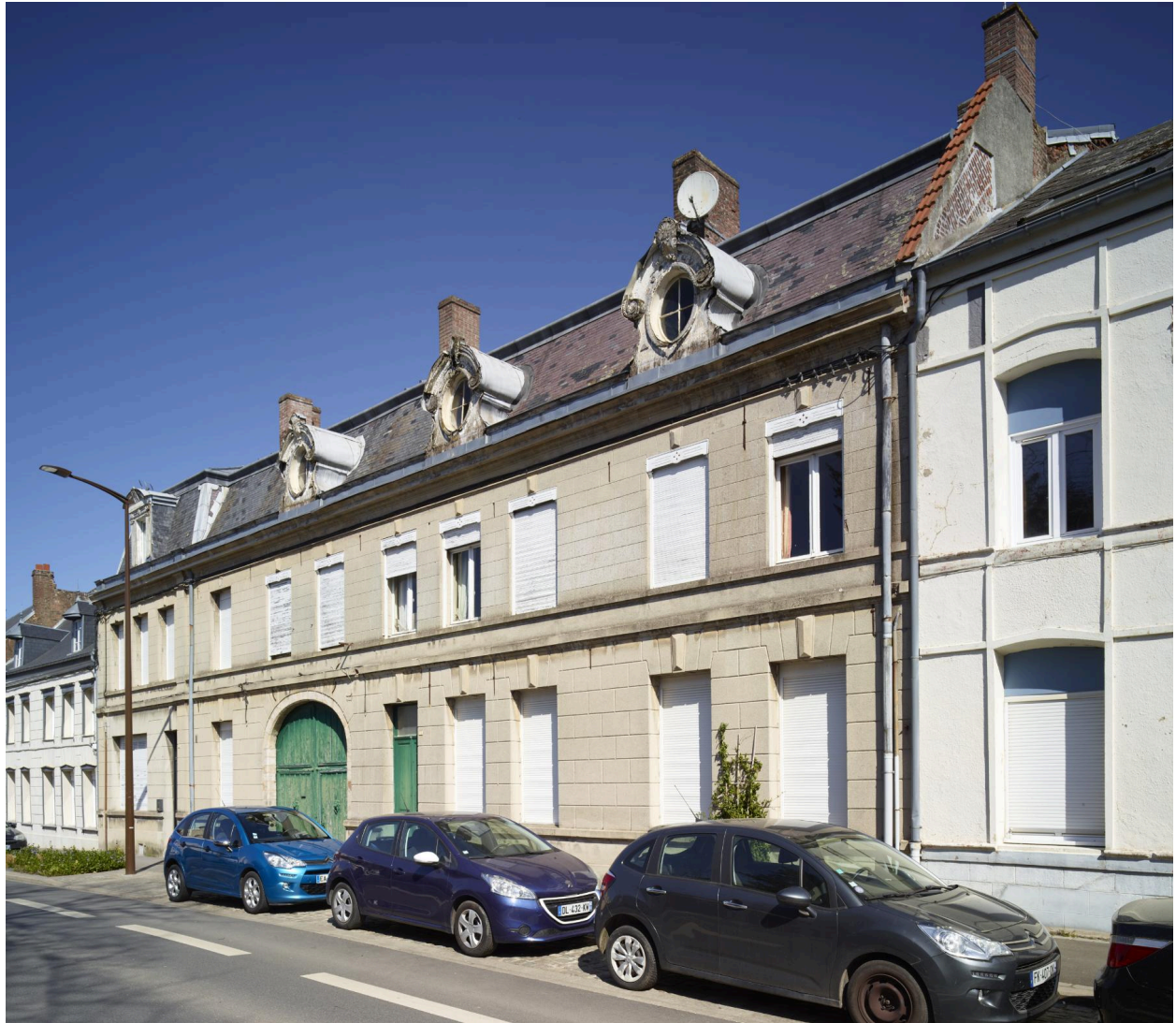
Maison avec toiture brisé, lucarnes "œil-de-bœuf" et pignons débordants - 25, rue de la Nouvelle-Zélande.
