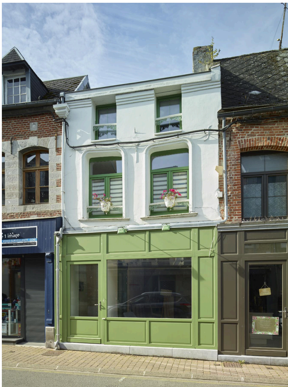
Maison à boutique - 11, rue Gambetta : exemple de bâti XVIIIe siècle sur lequel est venu se greffer une vitrine en applique du XIXe siècle, reprise récemment avec des huisseries en aluminium.
