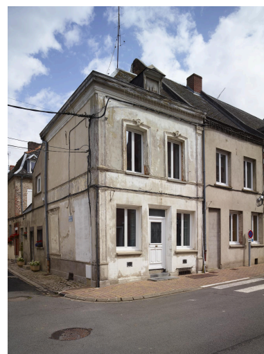
Maison XVIIIe siècle : façade avec une symétrie axiale mais un nombre différent de baies aux deux niveaux, porte au centre, baies du second niveau avec chambranle mouluré et décoré, niveaux de façade séparés par cordon larmier, chapiteaux composites et doriques - 18, rue Tanis. Phot. Pierre Thibaut IVR32_20245900279NUCA
