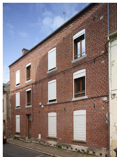
Maisons de trois niveaux du début du XIXe siècle - 16, rue Valory. Phot. Pierre Thibaut IVR32_20245900396NUCA
