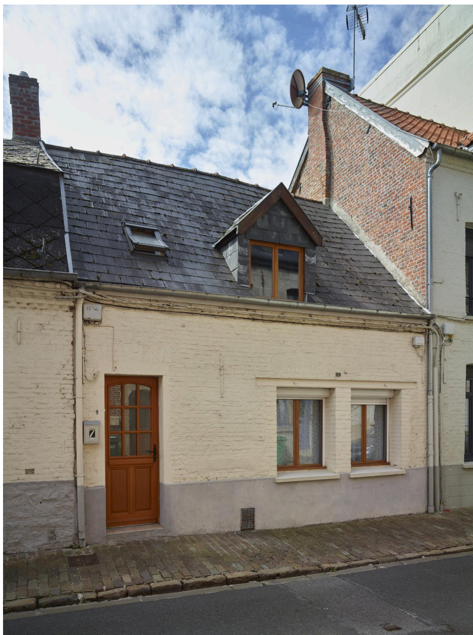
Maison - 7, rue Valory : exemple de maison en rez-de-chaussée avec un niveau de combles. Toutes les baies de la maison ont été reprises : le linteau en IPN en # est typique du milieu du XIXe siècle.
