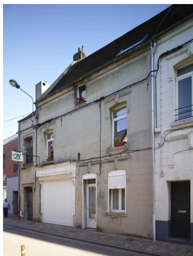
Maison, première moitié du XIXe siècle : chambranles partiels moulurés couronnés d'un linteau sur lequel vient brocher une grande agrafe trapézoïdale et s'achevant par des gouttes (trois au premier niveau et deux au second) - 4, rue Weibel. Phot. Pierre Thibaut IVR32_20245900908NUCA
