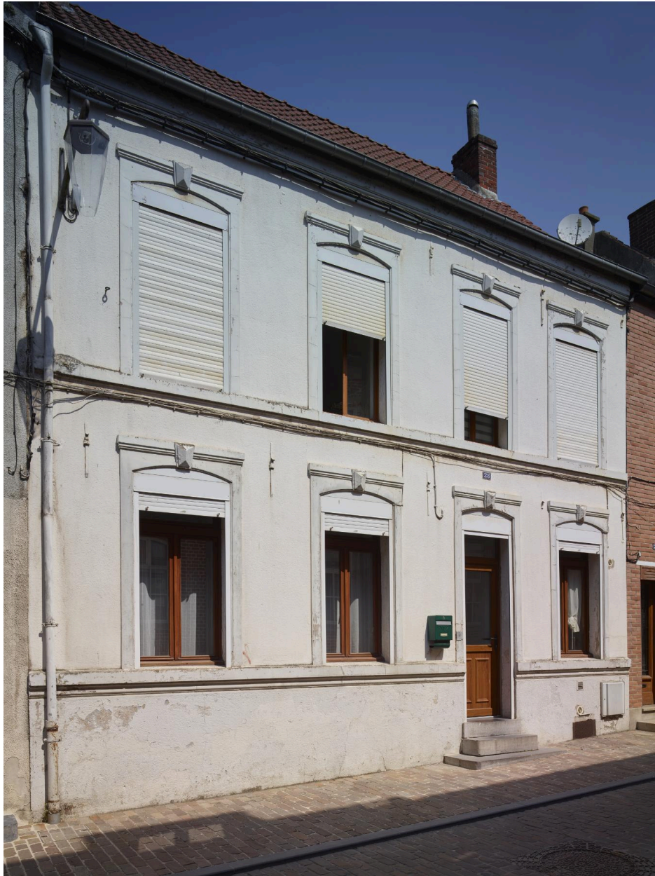
Maison du début du XIXe siècle avec porte précédée d'un degré - 28, rue Théau.
