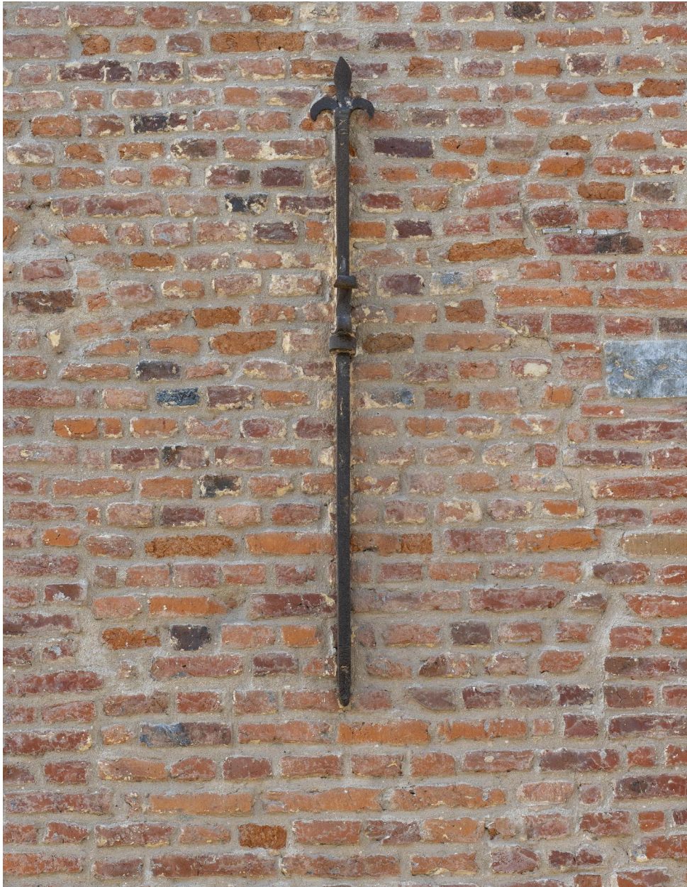
Fer d'ancrage simple, avec tête fleurdelysée, base décorée d'un motif d'arêtes de poisson et feuille enroulée sur le nœud sur une maison datée de la seconde moitié du XVIIe siècle - 9, rue Chevray.
