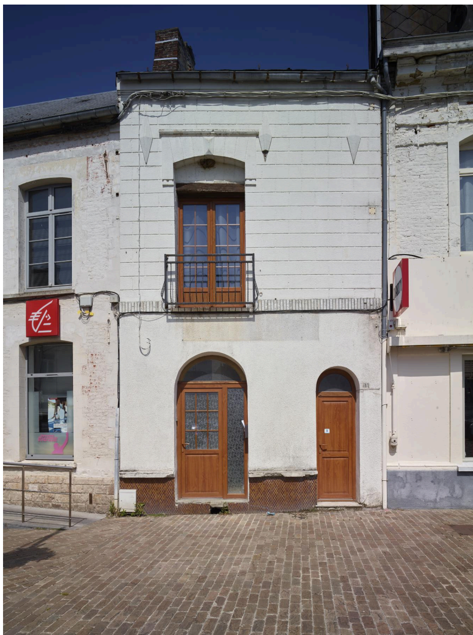
Maison datée du XIXe siècle : enduit en faux appareil au second niveau, décor de pointes de diamant insérées dans l'enduit, rare balcon - 22, place Leclerc.
