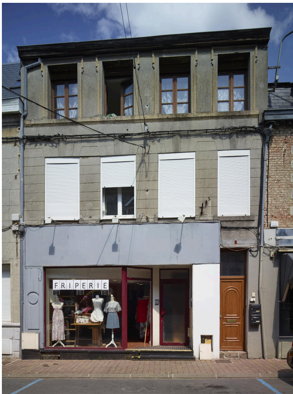
Immeuble de trois niveaux des XVIIIe et XIXe siècles - 10, rue Gambetta.
