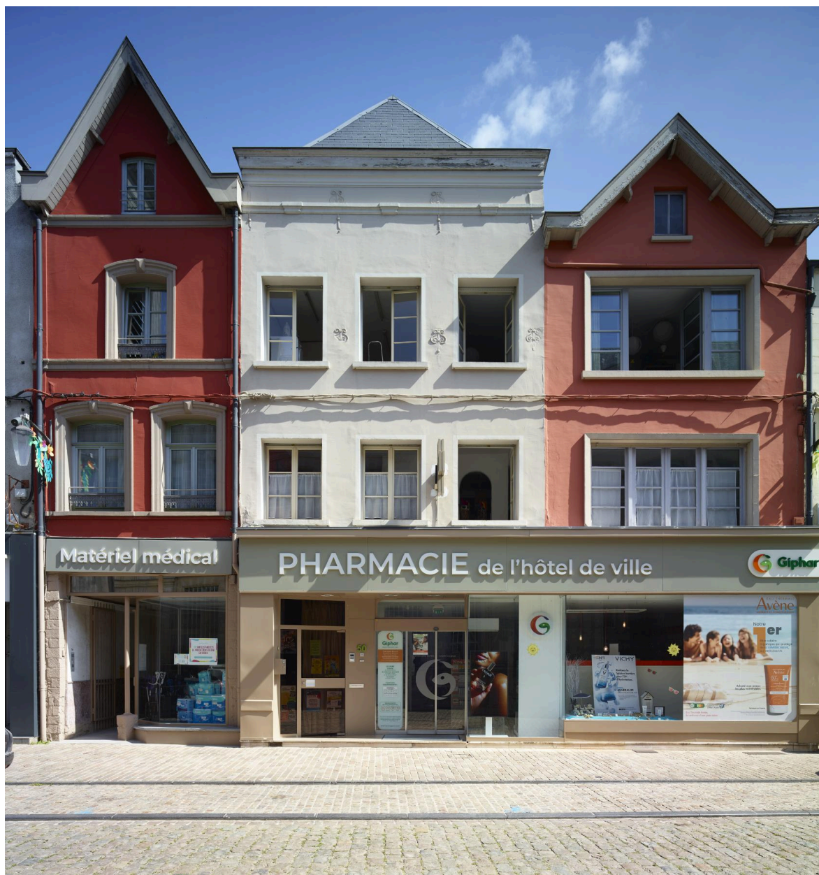
Maisons à boutique, rue Thiers : façades des XVIIe et XVIIIe siècle avec rez-de-chaussée modifiés dès le milieu du XIXe siècle par l'adjonction de vitrines, modernisées au cours du dernier quart du XXe siècle.
