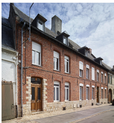
Maisons groupées de la seconde moitié du XVIIIe siècle, avec soubassement en grès et pieds-droits des portes bâtardes en chaîne harpée en grès, grilles de protection et impostes des portes en fonte décorées - 4 et 6, rue de la Couronne.
