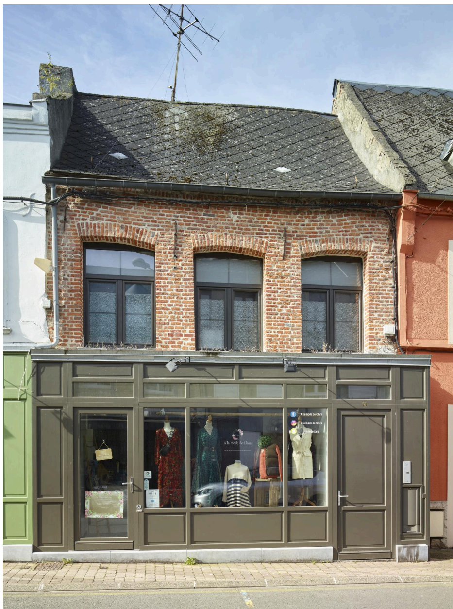
Maison à boutique - 13, rue Gambetta : exemple de bâti XVIIIe siècle sur lequel est venu se greffer une vitrine en applique du XIXe siècle, reprise récemment avec des huisseries en aluminium.
