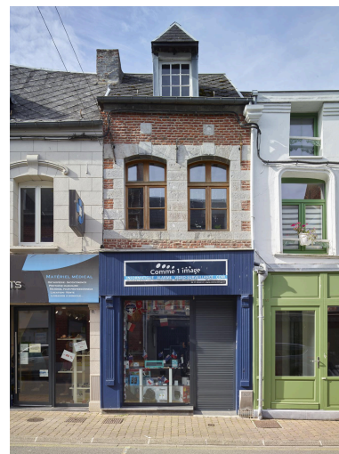
Maison à boutique - 9, rue Gambetta : exemple de bâti XVIIIe siècle sur lequel est venu se greffer une vitrine en applique du XIXe siècle dont subsistent les piliers latéraux. Les baies du second niveau sont entièrement entourées en pierre bleue et leurs clefs de voûte portent la date de 1748. Phot. Pierre Thibaut IVR32_20245900839NUCA
