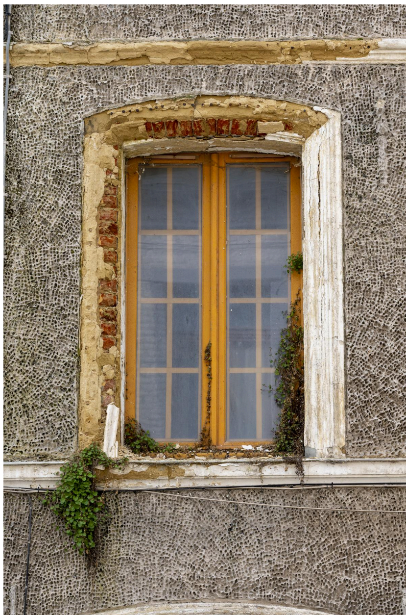
Maison, 5 rue des Lombards : détail d'une des fenêtres qui montre l'application d'un enduit sur une structure de brique pour réaliser les moulures du chambranle à cru typique du XVIIIe siècle.
