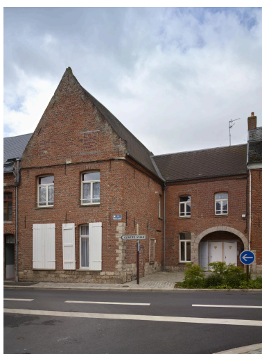
Maison, limite XVIIe-XVIIIe siècles, avec pignon débordant (ou wambergue) construit en coins de brique (ou épis) - 15, rue de la Nouvelle-Zélande.
