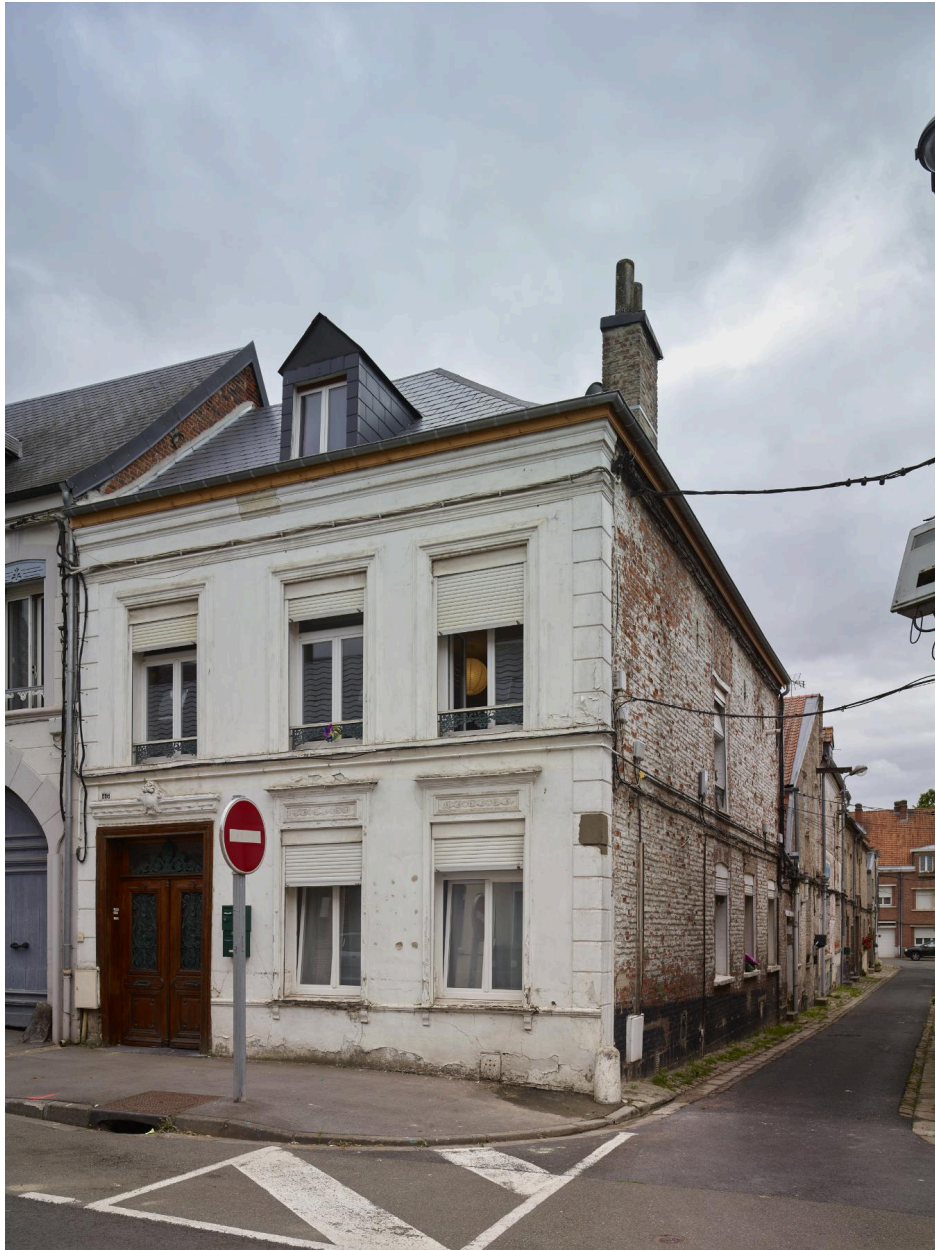
Maison limite XVIIIe-XIXe siècles : linteaux décorés d'un rang de perles et de fleurs en frises, agrafe baroque, façade avec enduit lisse et jambes à tambour, façade latérale en brique nue, garde-corps tripartites doubles en fonte moulée à décors de rinceaux, porte bâtarde avec grille de protection et imposte en fonte moulée à motifs - 45, rue Thiers.
