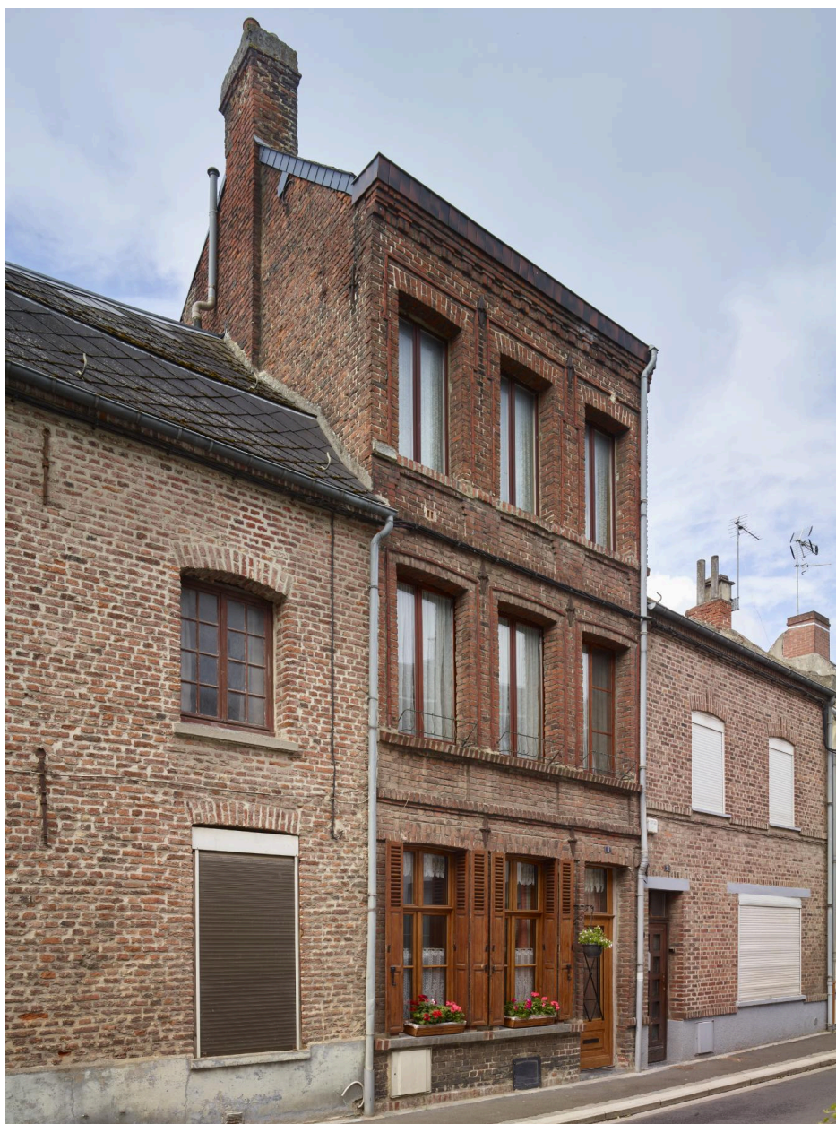
Maison de trois niveaux du troisième quart du XIXe siècle - 1, rue de la Nouvelle-Zélande.
