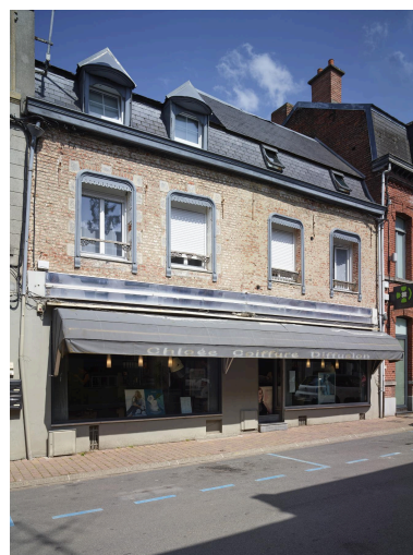
Maison à boutique - 8, rue Gambetta : exemple de bâti XVIIIe siècle sur lequel est venu se greffer une vitrine en applique du XXe siècle. Phot. Pierre Thibaut IVR32_20235901105NUCA
