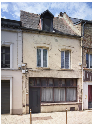
Maison datée du 3ème quart du XIXe siècle, avec chambranles à crossettes partiels entièrement en briques - 7, rue Weibel. Phot. Pierre Thibaut IVR32_20245900049NUCA
