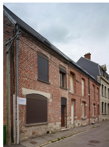
Maisons groupées de la charnière XVIIIe-XIXe siècle - 28-32, rue Carlier. Phot. Pierre Thibaut IVR32_20245900172NUCA
