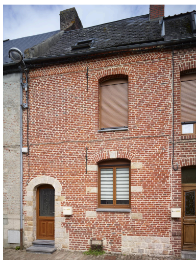
Maison XVIIIe siècle : soubassement en grès, porte avec encadrement cintré en grès, éléments en bossage en grès dans la baie, degrés en pierre bleue, entrée de soupirail soulignée par linteau en grès et motifs d'arêtes de poisson et de dents d'engrenage pour la corniche sommitale - 10, rue Valory. Phot. Pierre Thibaut IVR32_20245900394NUCA
