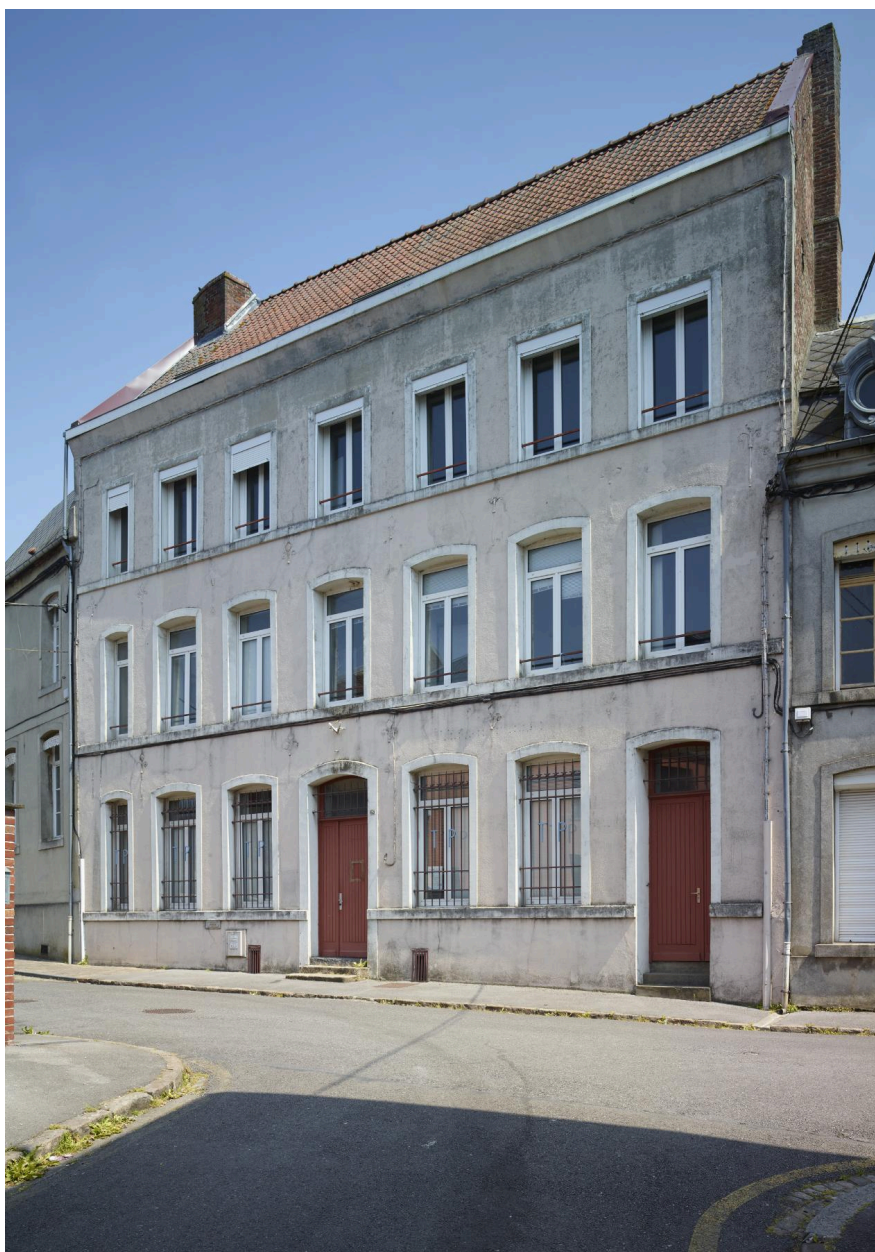
Ancien ouvrier de l'orphelinat des sœurs de la Charité, puis immeuble de bureaux (Trésor Public), actuellement immeuble à logements - 26-28, rue des Lombards.
