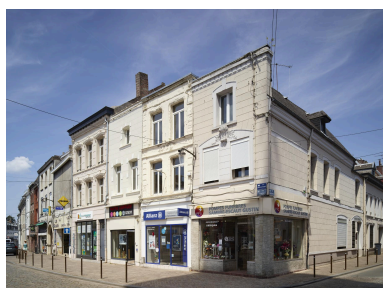
Maison fin XVIIIe siècle : façade rideau en partie haute (décor refait à la Première Reconstruction), toiture à longs pans - 2, rue Thiers. Phot. Pierre Thibaut IVR32_20235901059NUCA
