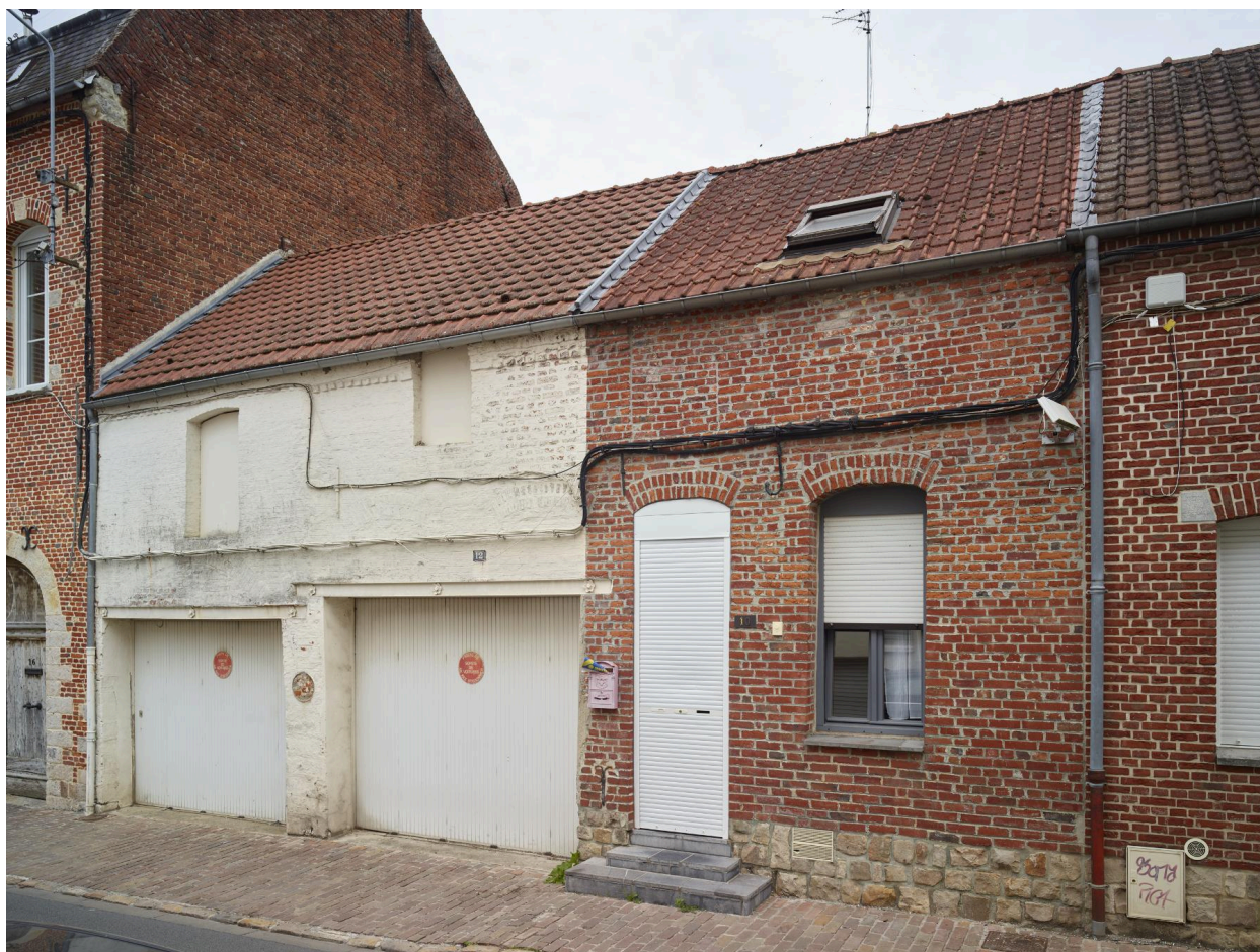
Ancien bâtiment reconvertit en garage au début du XXe siècle, reconnaissable à ses linteau en fer décorés de rosettes - 10-12, rue Bouttiaux.
