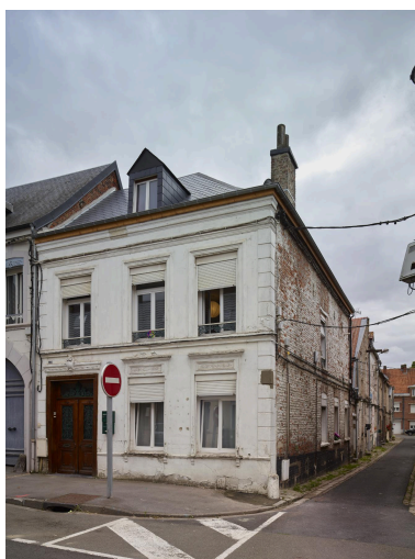
Maison limite XVIIIe-XIXe siècles : linteaux décorés d'un rang de perles et de fleurs en frises, agrafe baroque, façade avec enduit lisse et jambes à tambour, façade latérale en brique nue, garde-corps tripartites doubles en fonte moulée à décors de rinceaux, porte bâtarde avec grille de protection et imposte en fonte moulée à motifs - 45, rue Thiers. Phot. Pierre Thibaut IVR32_20245900830NUCA
