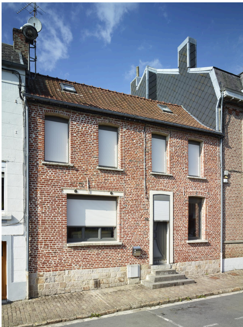
Maison du XVIIIe siècle : reprise des baies à la fin du XIXe siècle visible sur le linteau en fer en #, porte précédée d'un degré - 34, rue Baillon.
