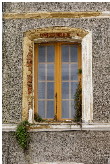
Maison, 5 rue des Lombards : détail d'une des fenêtres qui montre l'application d'un enduit sur une structure de brique pour réaliser les moulures du chambranle à cru typique du XVIIIe siècle. Phot. Pierre Thibaut IVR32_20255900240NUCA
