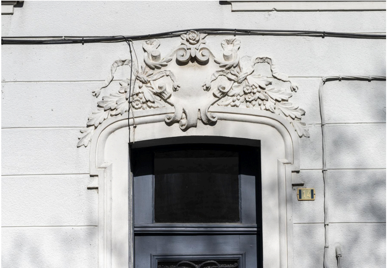
Maisons du XIXe siècle : détail du décor figuratif rapporté au-dessus de la porte et du décor enduit en boosage plat - 14, rue de l'Aulette.
