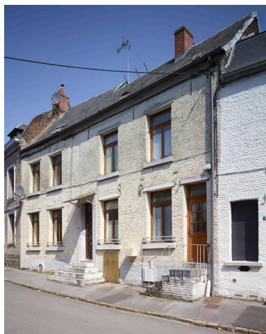
Maisons groupées datées de 1867 (date portée dans les fers d'ancrage) - 14-16, rue des Lombards. Les maisons présentent à la fois un imposant degré et un escalier latéral avec mur d'échiffre en brique. Phot. Pierre Thibaut IVR32_20235900973NUCA
