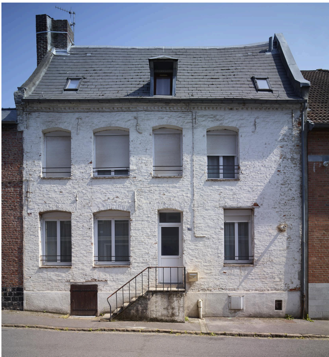
Maison avec escalier à volée droite et mur d'échiffre en brique - 20, rue des Lombards.
