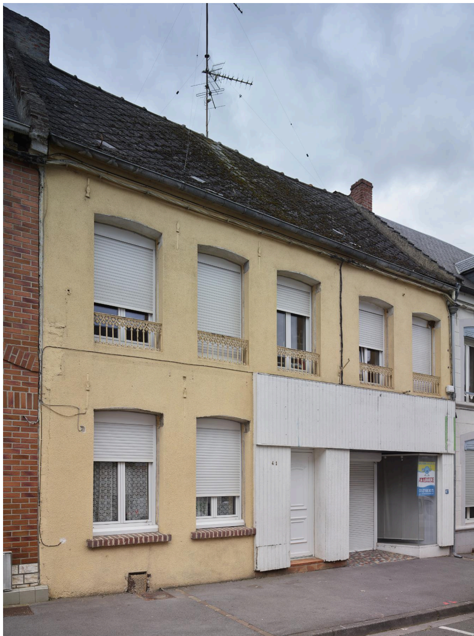
Maison, première moitié du XVIIIe siècle : pignons débordants, façade ordonnancée à 5 travées reprise au 1er niveau dans les années 1950, garde-corps panneau en fonte à motifs de lancettes et fleurons - 41, rue Thiers.
