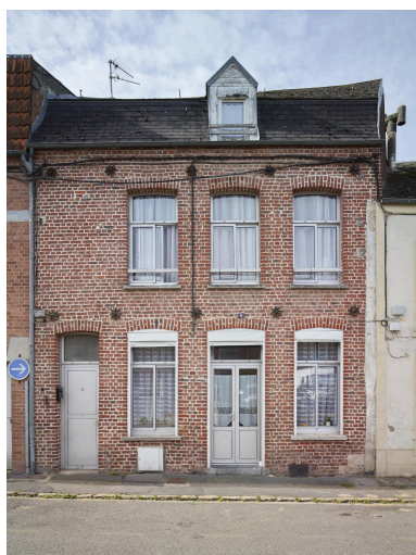
Maisons groupées du premier quart du XIXe siècle - 9-11, rue Juhel. Phot. Pierre Thibaut IVR32_20245900852NUCA
