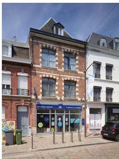
Maison à pignon sur rue avec toiture à longs pans et croupe, 1ère moitié du XVIIIème siècle - 10, place du Général-Leclerc. Phot. Pierre Thibaut IVR32_20235901053NUCA
