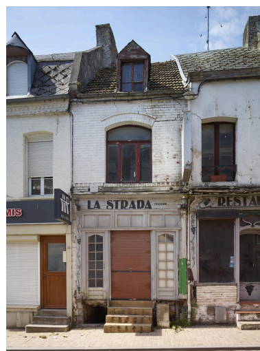
Maison datée de la première moitié du XIXe siècle : rez-de-chaussée surélevé avec degré, façade en briques posées en appareil picard badigeonnées, une seule baie soulignée par une archivolte en brique au second niveau, fers d'ancrage tige avec feuille sur le nœud, garde-corps en fonte moulée à motifs de rinceaux, vitrine en applique
