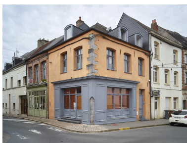
Maison à boutique - 19, rue Thiers : exemple de bâti XVIIe siècle signalé par la présence d'une chaîne harpée, modifié au XIXe siècle par l'adjonction d'une vitrine en applique. Phot. Pierre Thibaut IVR32_20245900040NUCA
