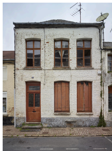
Maison du XVIIIe siècle : pignon sur rue, façade organisée à travées, porte à gauche, grille de protection de la porte avec motifs Art Nouveau (ligne coup de fouet) - 8, rue Baillon. Phot. Pierre Thibaut IVR32_20245900372NUCA
