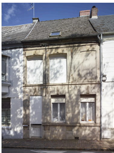
Maison, seconde moitié du XVIIIe siècle, avec trois travées et porte située à gauche, façade enduite en faux appareil avec refends et baies décorées d'agrafes en pointe de diamant - 16, rue de l'Aulette. Phot. Pierre Thibaut IVR32_20245900054NUCA
