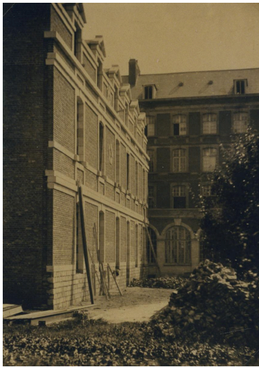
Quartier des hôtes. Photographie, avant 1903. Phot. Pierre Thibaut IVR32_20225900190NUCAB
