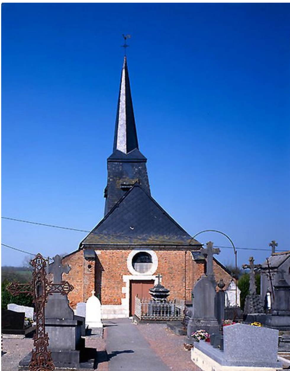
Vue de la façade occidentale.
