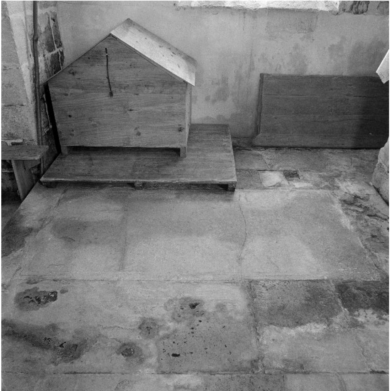
Vue générale de la dalle.
