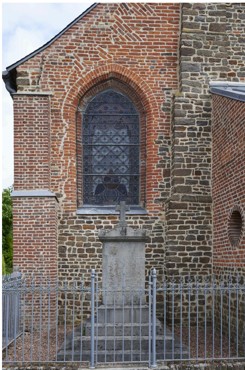
Détail de la façade principale. Enclos funéraire et tombeau du XIXe siècle.
