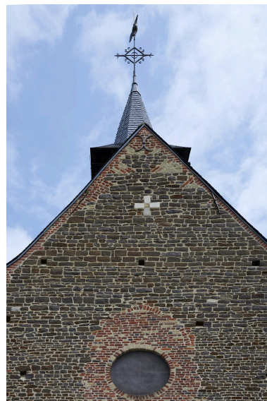
Détail du pignon de la façade principale (ouest). Phot. Delphine Volto Jourdan IVR32_20235901116NUCA
