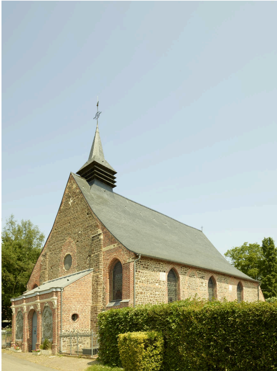
Façade et bas côté sud de l'église.
