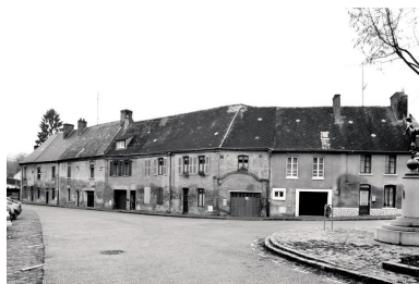
Vue de l'élévation sur la place.
