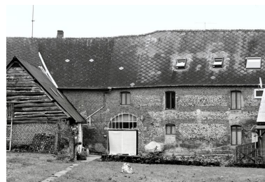
Vue de l'élévation postérieure sur la cour, construite en silex et brique.
