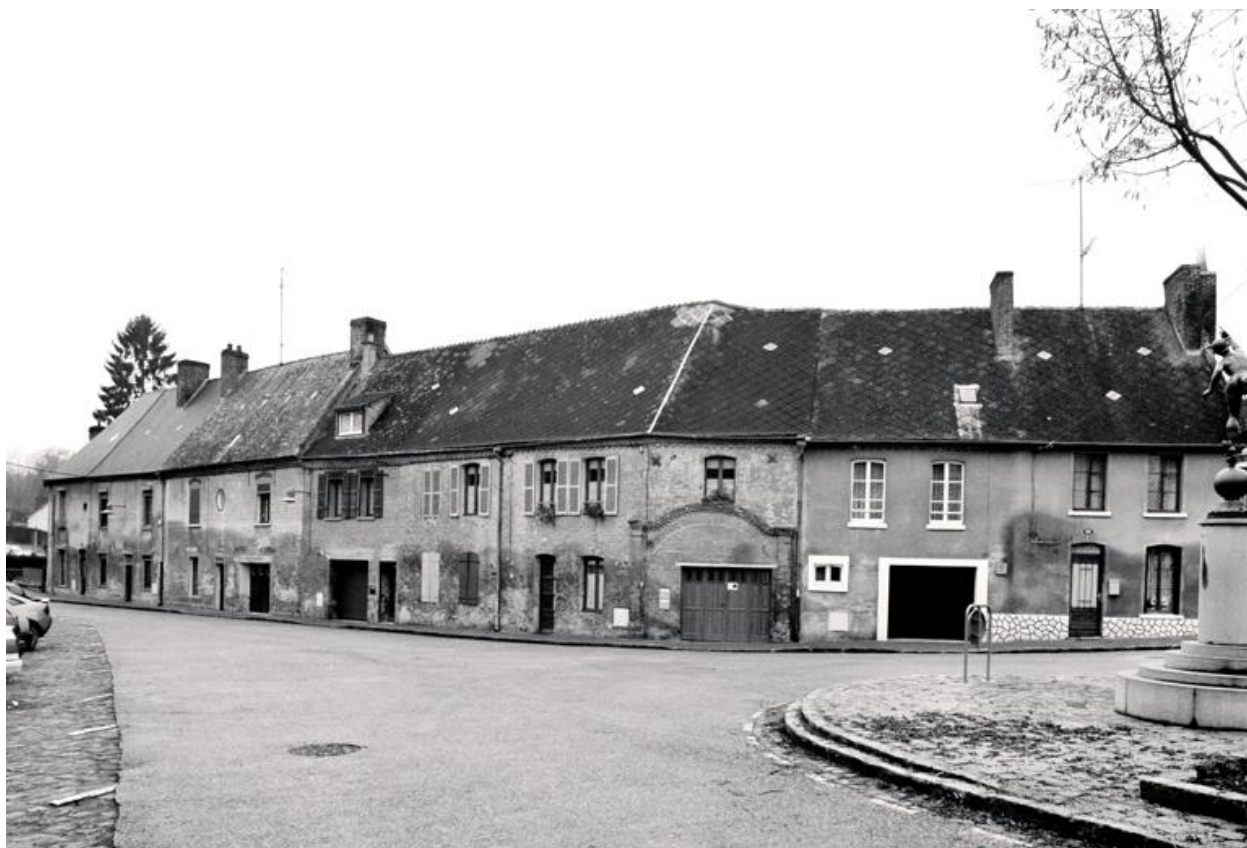
Vue de l'élévation sur la place.
