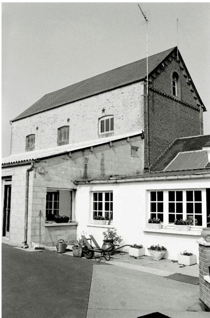
Vue des anciennes parties des ateliers.
