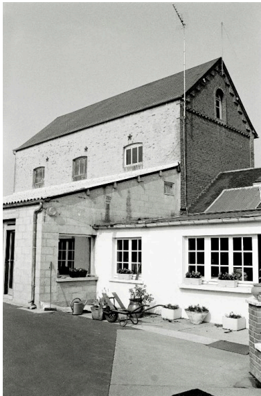
Vue des anciennes parties des ateliers. Phot. Benoît Dufournier IVR22_19908000316Z
