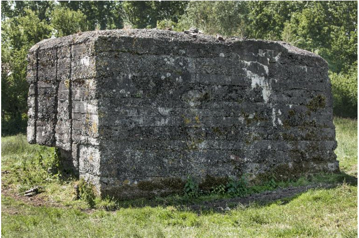
Vue de trois-quarts cers le sud-est
