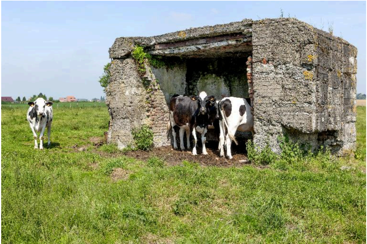
Vue de trois-quarts, vers le nord-ouest
